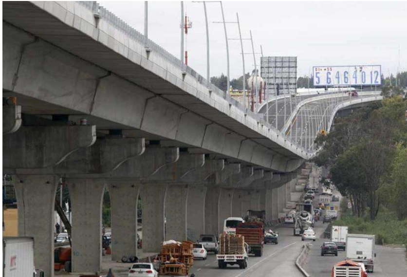
Figura 12. Segundo piso de la autopista México-Puebla, que inicia en la planta de la Volkswagen y termina adelante del estadio Cuauhtémoc. Es una vía rápida de peaje, por lo que existe un acceso diferencial a ella entre quienes pueden cubrir el costo y atravesar la ciudad de Puebla en poco tiempo y quienes quedan atrapados en el pesado tráfico de la planta baja. 63
