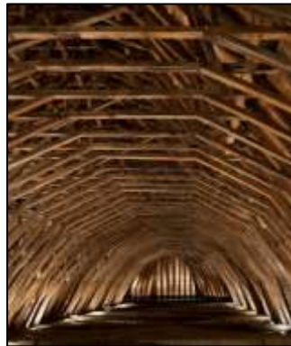
Figura 1.1 Imagen de la armadura de Sait-Girons, en Monein, Francia
