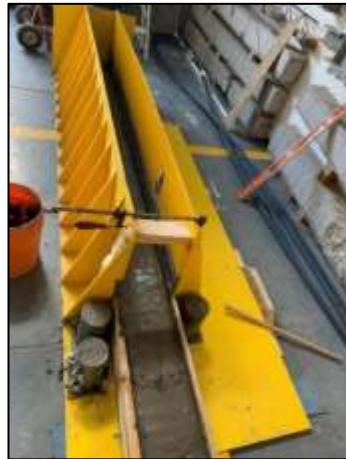
Figura 3.10 Colado del muerto
