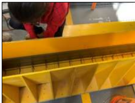
Figura 3.8 Armado de muerto
