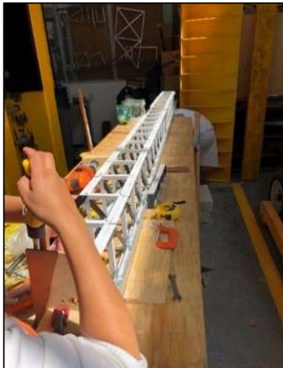
Figura 3.7 Construcción de armadura fase 2
