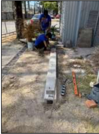
Figura 14 Excavación y colocación del muerto.
