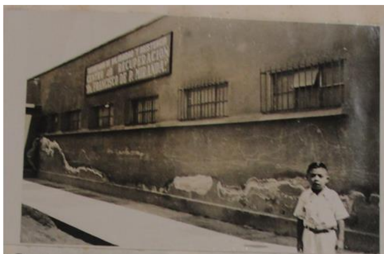
Figura 6. Centro de Recuperación Infantil Francisco de P. Miranda.
