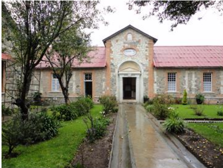
Figura 2. Segundo edificio del ex-hospital minero. Fuente. Fotografías del autor, enero de 2015. Sala. Hoy museo de Medicina Laboral.
