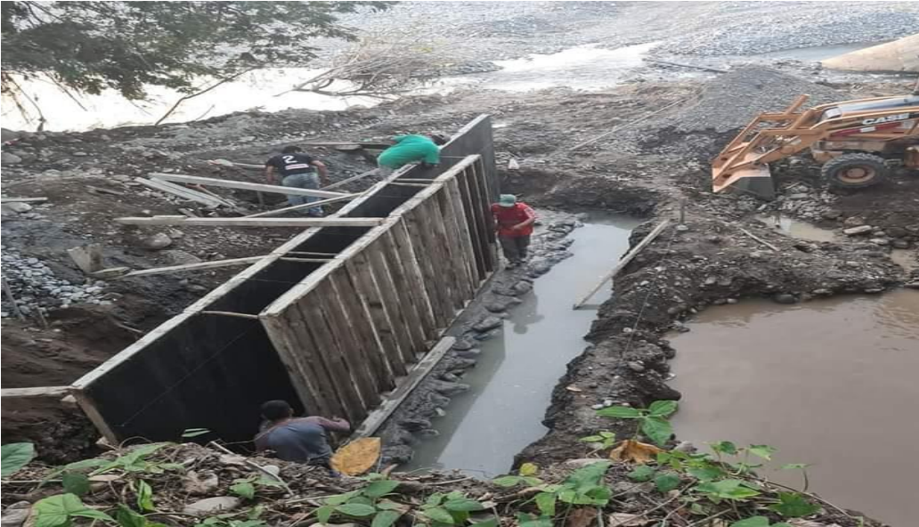
Ilustración 28. Trabajo de construcción. Fuente: Lauro Becerra García
