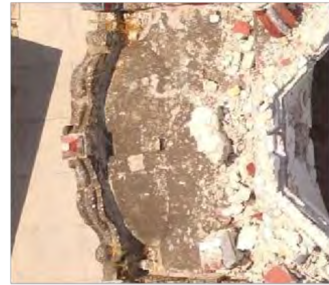
Imagen 2: Vista exterior de bóveda de presbiterio
