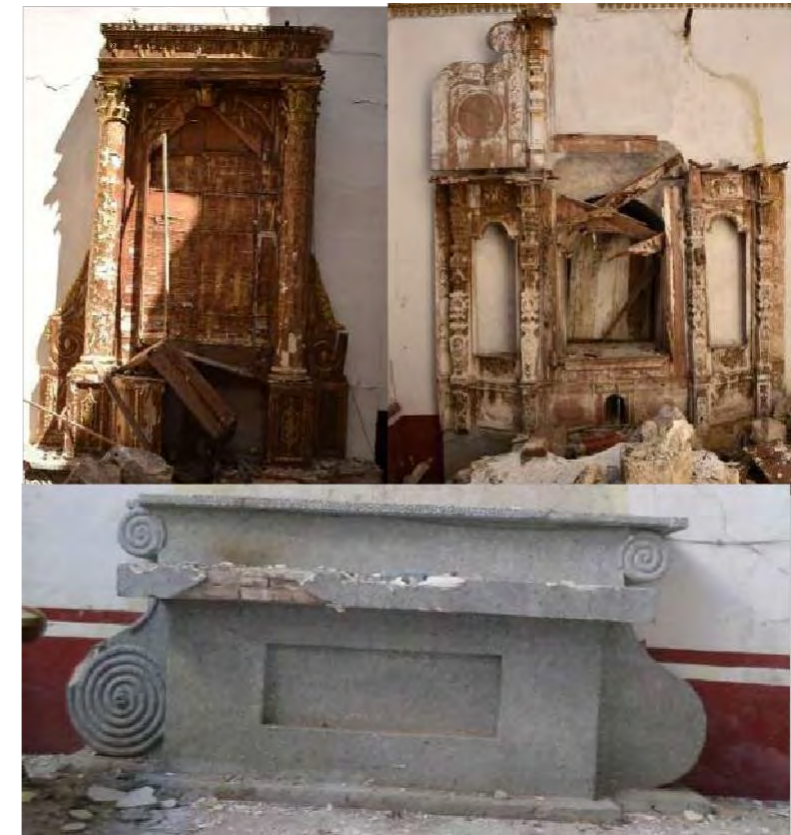
Imagen. 35. Retablos de madera ubicados en el tramo 1 y una de las credenzas de piedra que se encuentran en el tramo 2 de la nave.
