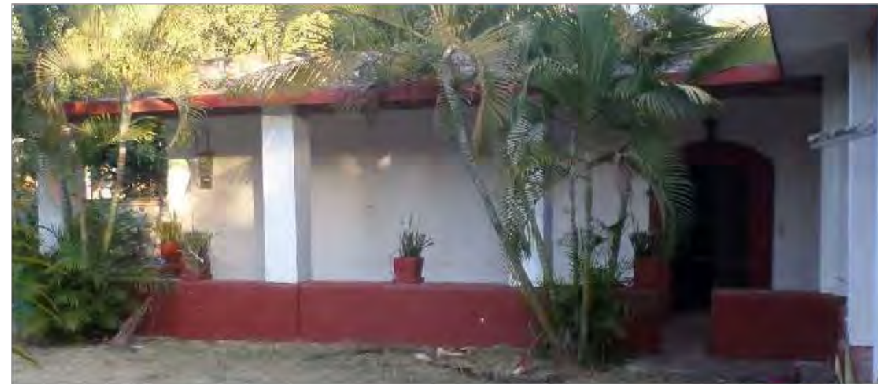
Imagen 1: Muro exterior poniente de bodega 1 y bodega 2
