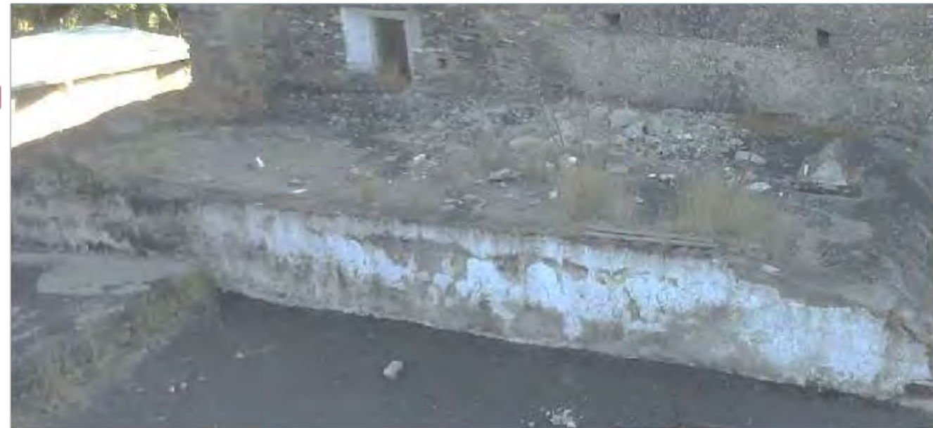
Imagen 1. Vista en azotea de las bóvedas de sacristía, anexo a sacristía y anexo 2
