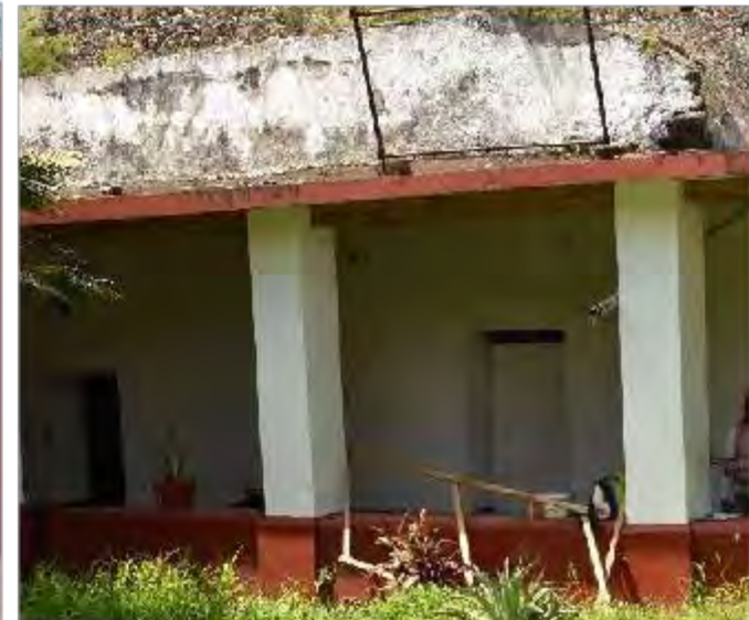
Imagen 2: Fachada Norte de Anexo a Sacristía y Anexo 2
