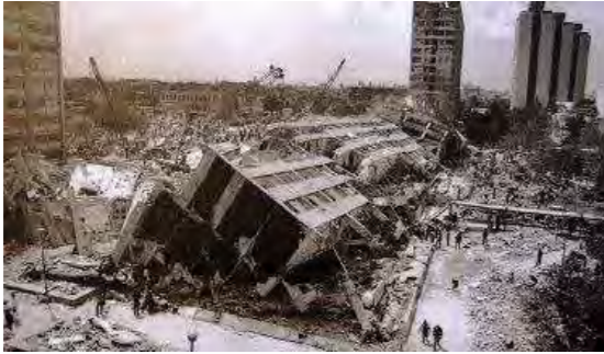
Imagen 1. Daños del sismo en México (1985)
