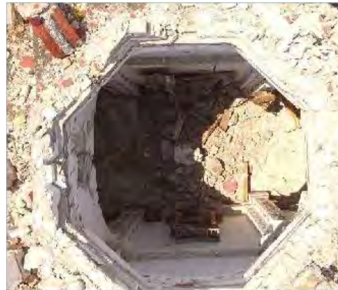
Imagen 1: Vista exterior del área donde se encontraba la cúpula en Nave tramo 2
