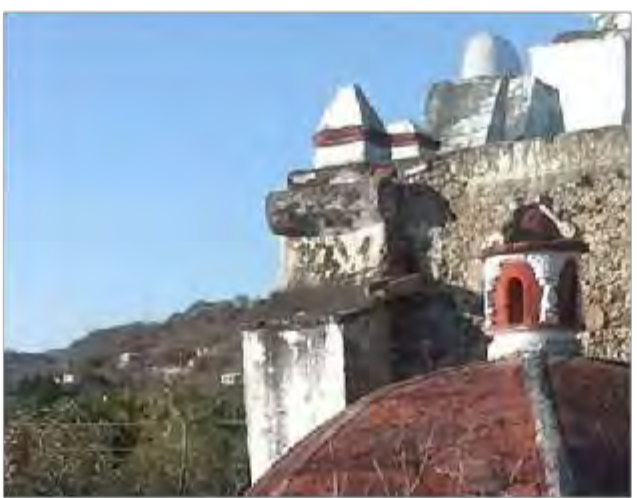
Imagen 1: Remate de contrafuerte de Eje 1
