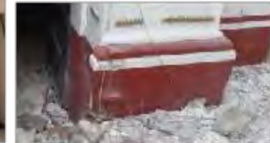
Imagen 4. Detalle de basa de pilastra
