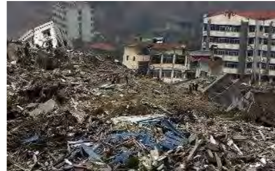
Imagen 4. Daños del Sismo de Haití (2010)
