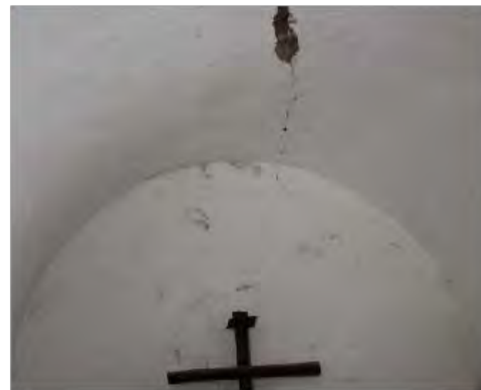
Imagen 2. Vista interior de la bóveda de sacristía
