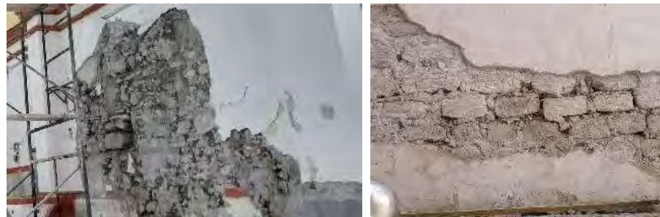
Muros conformados por diferentes materiales
