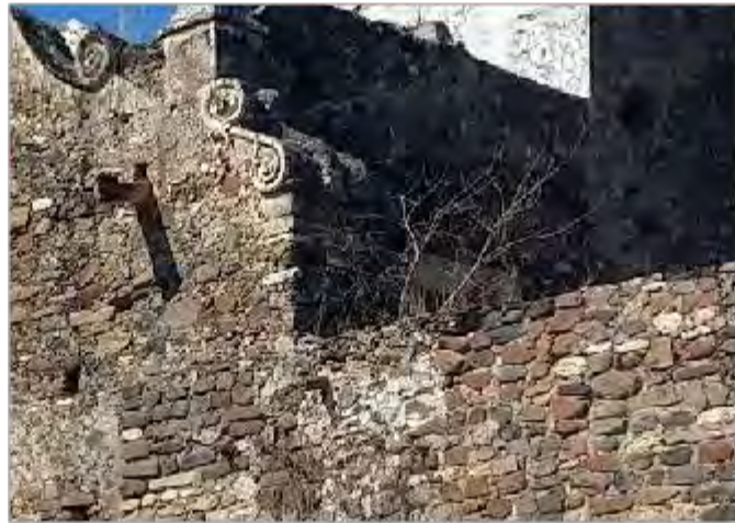
Imagen 1: Vista poniente del contrafuerte de Eje 6 fachada norte
