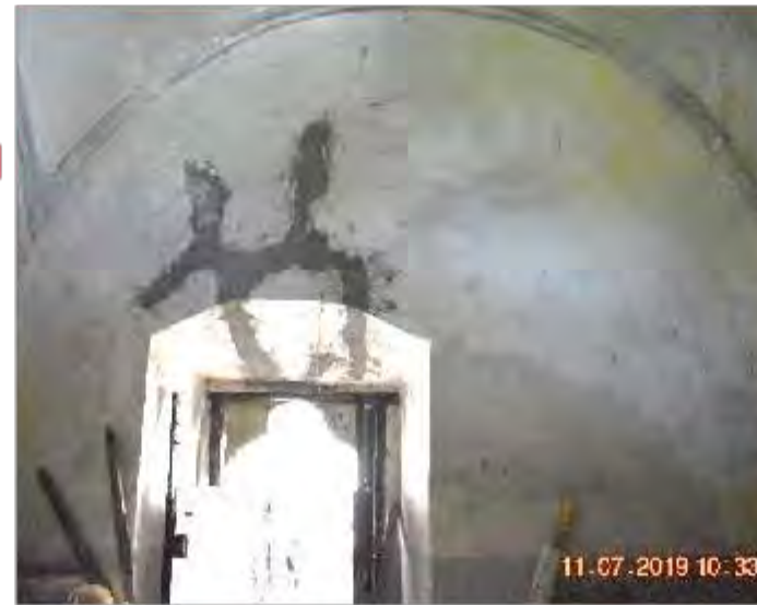
Imagen 1: Muro interior norte de Baptisterio
