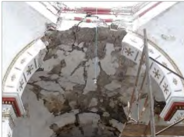
Imagen 3: Arco fajón Tramo 1-Tramo 2
