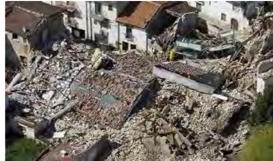
Imagen 2. Daños del sismo en L'Aquila, Italia (2009)
