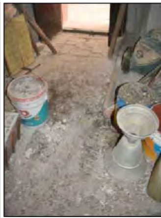
F06. Acabado de piso del Baptisterio
