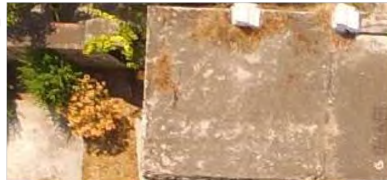
Imagen 3. Vista de azotea de cubierta de bodega 2
