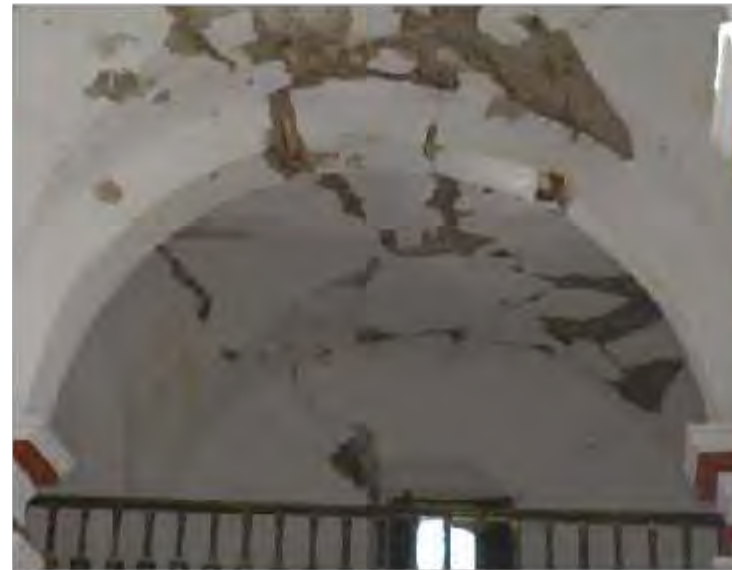
Imagen 1: Arco fajón de Coro-Tramo 1
