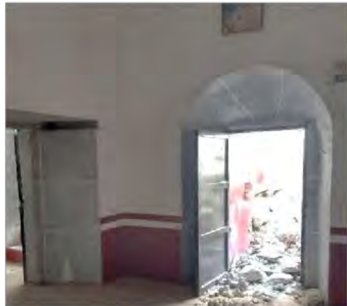
Imagen 4: Muro interior sur de Anexo a sacristía
