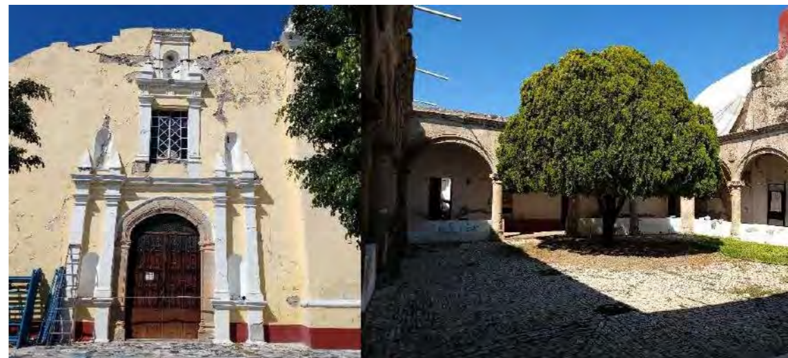
Imagen 5. Fachada principal de la capilla del Ex Convento de Tepapayeca (izquierda), Claustro del Ex Convento de Tepapayeca (derecha). Fuente: Sánchez Paulino, 2018.
