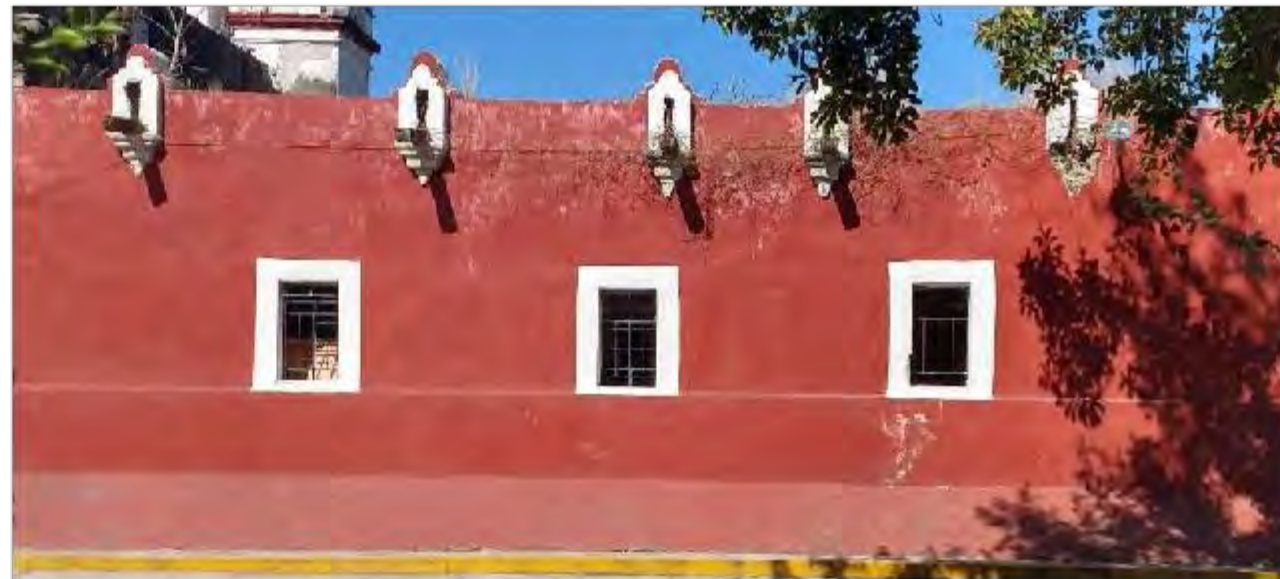
Imagen 2: Muro exterior oriente de bodega 1 y 2
