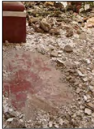
F01. Acabado del piso en Presbiterio
