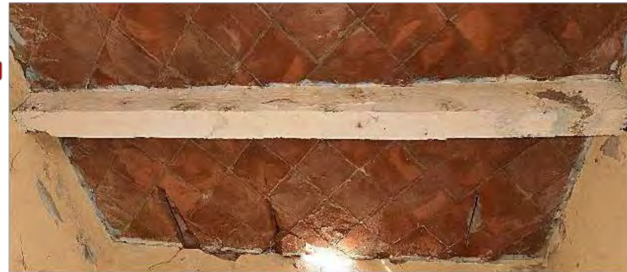
Imagen 1. Vista interior de cubierta de bodega 2
