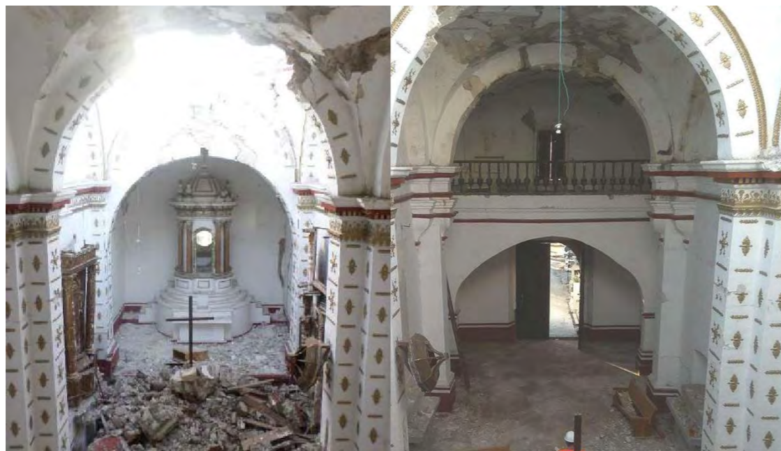
Imagen. 18. Vista desde primer tramo de la nave al hacia el presbiterio (izquierda), vista desde el tramo dos de la nave hacia el sotocoro (derecha).
