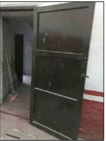
F05. Puerta de madera transición de sacristía a nexo de sacristía
