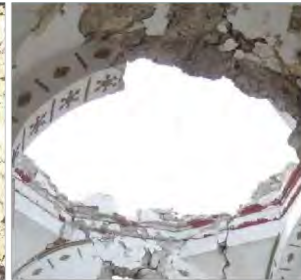
Imagen 2: Vista interior del área donde se encontraba la cúpula en Nave tramo 2
