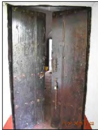
F06. Puerta de madera transición patio norte a Anexo 1
