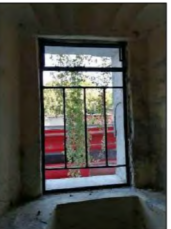
F06. Ventana de herrería de bodega, vista interior
