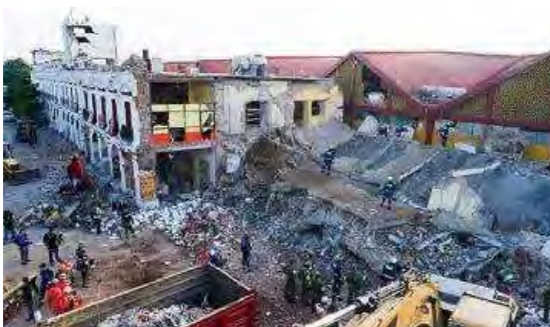
Imagen 5. Daños del Sismo de México (2017)
