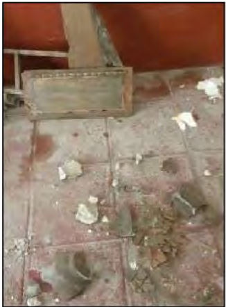
F03. Acabado de piso en anexo a sacristía
