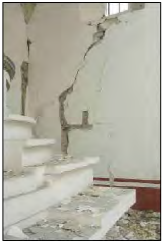
F02. Muro interior sur de presbiterio
