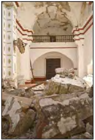
F01. Escombro producto de cúpula, bóveda agrietada
