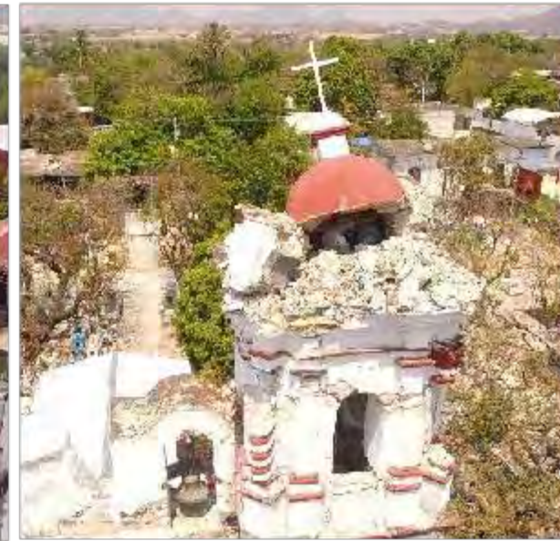
Imagen 2. Vista exterior oriente de cúpula de torre campanario
