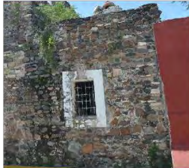
Imagen 1: Muro exterior de Sacristía (fachada oriente)
