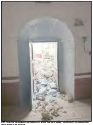
F03. Muro de nexo a sacristía con vista hacia la nave, mostrando el escombro del colapso de cúpula
