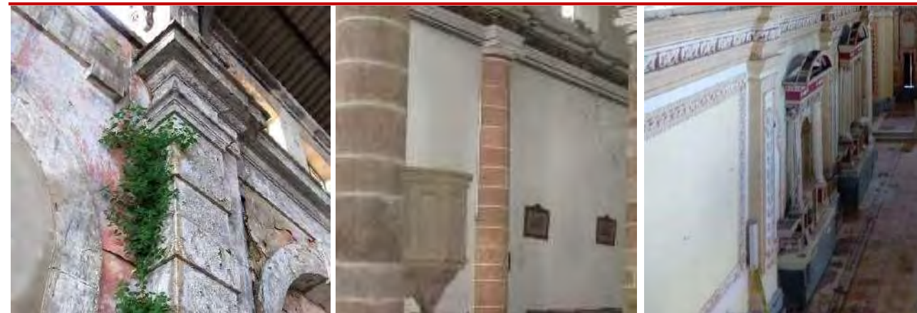
Columnas compuestas por diferente fábrica
