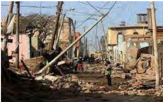
Imagen 3. Daños del sismo en Chile (2010)
