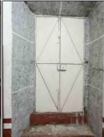
F04. Puerta metálica transición de sacristía a presbiterio
