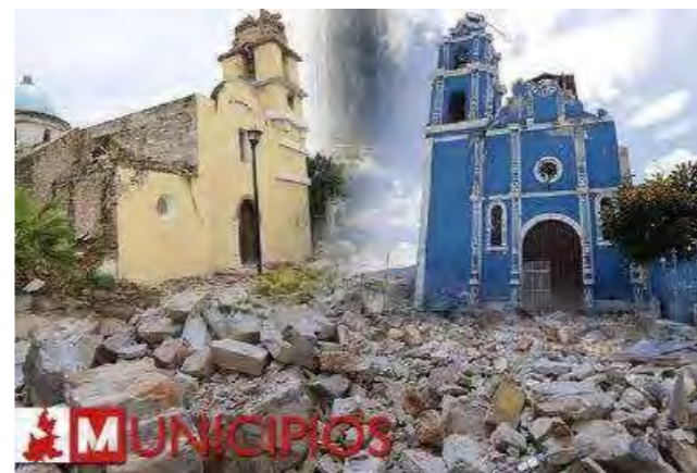
Imagen 11. Daños del Sismo de México (2017) Fuente: https://admin.municipiospuebla.mx/sites/
