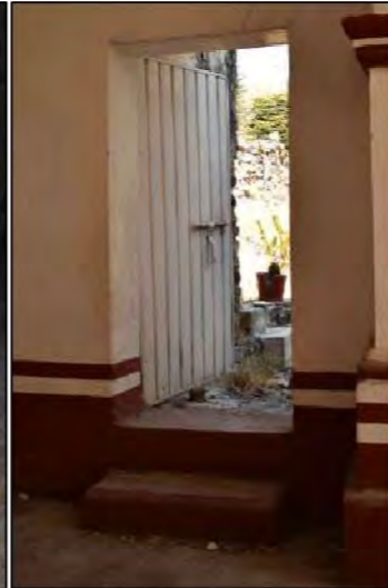
F02. Puerta metálica de acceso a templo por jardín
