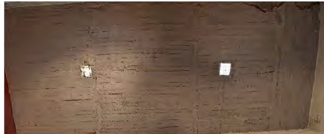
Imagen 3. Vista de azotea de cubierta de bodega 1
