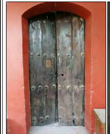
F05. Puerta de madera de acceso a bodega 1
