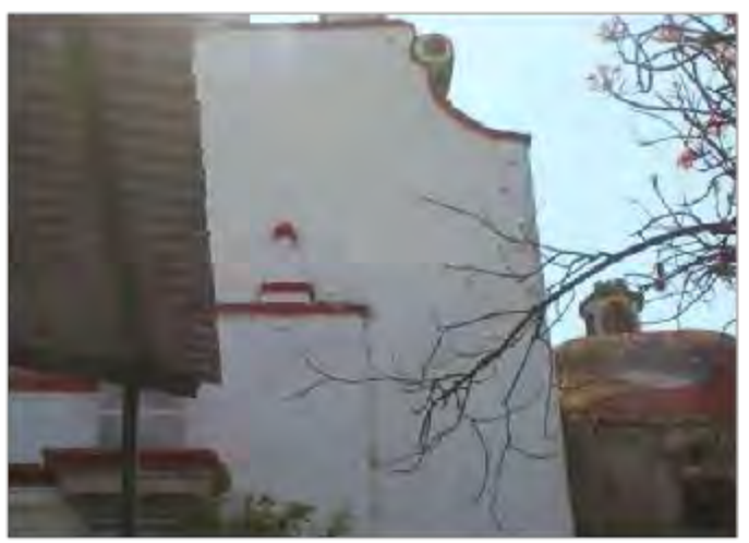
Imagen 2: Fachada Poniente de contrafuerte de Eje 1
