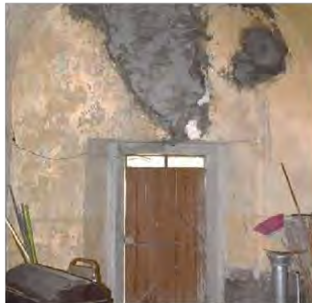
Imagen 3: Muro interior Norte de Anexo 2
