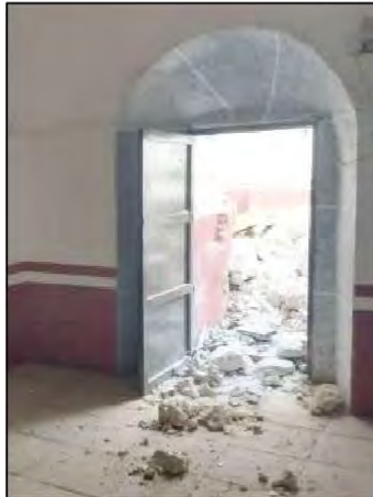
F03. Puerta de madera transición de nexo a sacristía a nave
