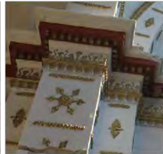
Imagen 3. Detalle del capitel de pilastra Norte de Nave Tramo 2 Vista Frontal
