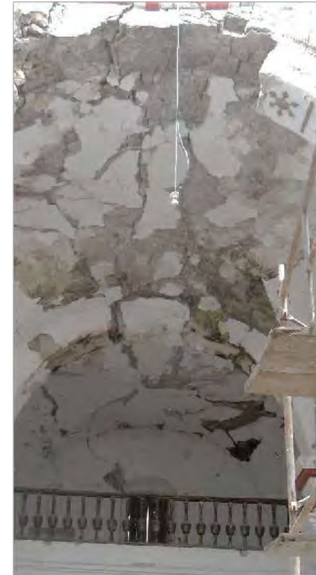
Imagen 2: Vista interior de cubierta de coro y de nave tramo 1
