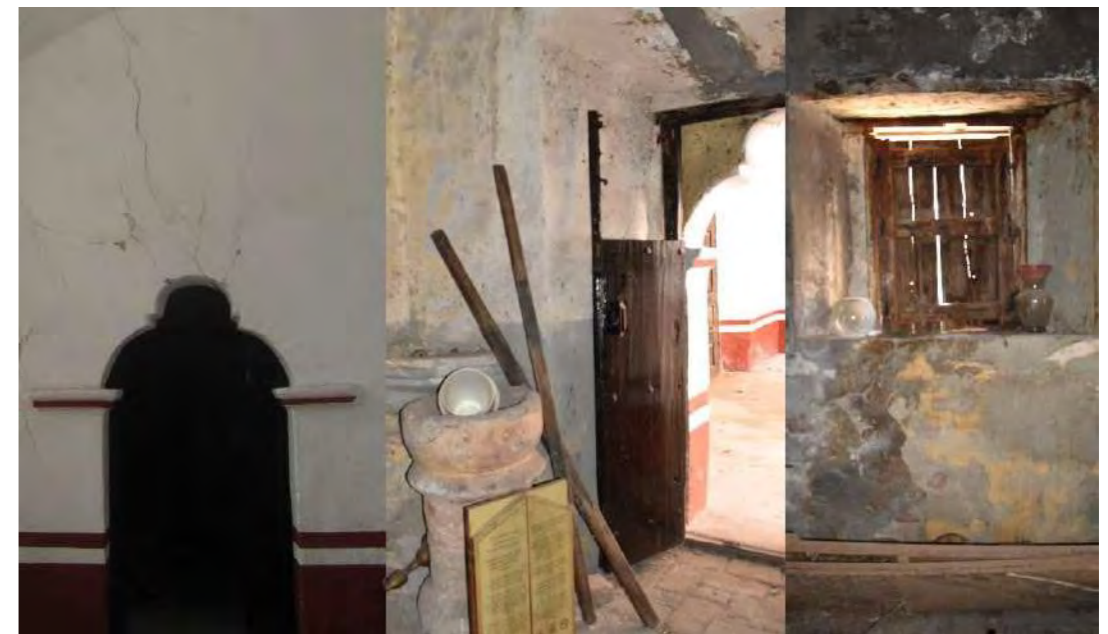
Imagen. 37. Vista del acceso al baptisterio desde el sotocoro (izquierda), interior del baptisterio con vista hacia la puerta de acceso y ventana que da hacia el atrio. Fuente: Sánchez Paulino, 2018.
