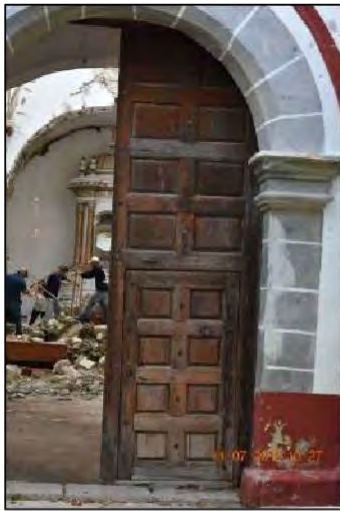
F01. Portón de madera acceso al templo, vista exterior
