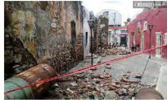
Imagen 6. Daños del Sismo de México (2017)
