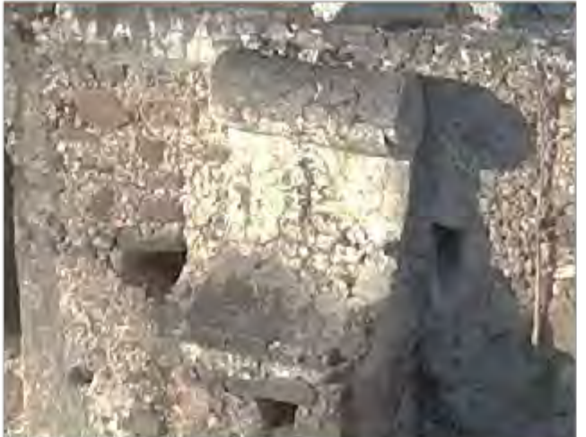
Imagen 2: Detalle de remate de contrafuerte de Eje 4
