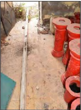
F05. Acabado de piso de Bodega 2
