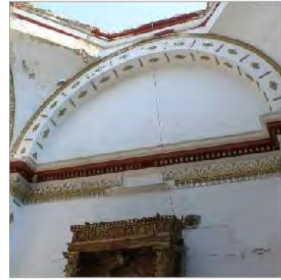
Imagen 2: Arco formero de Tramo 2
