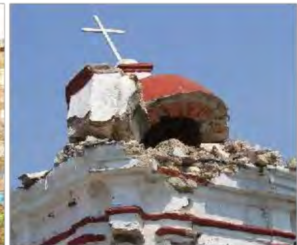
Imagen 4. Vista exterior suroriente de cúpula de torre campanario
