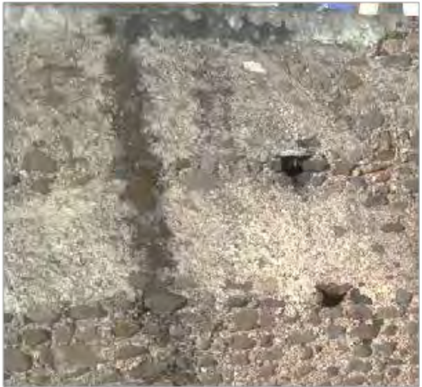
Imagen 2: Muro de fachada Sur
