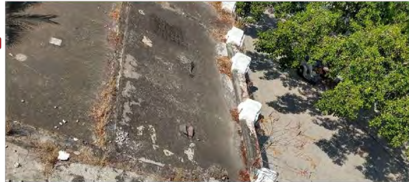
Imagen 1. Vista de azotea de cubierta de bodega 1
