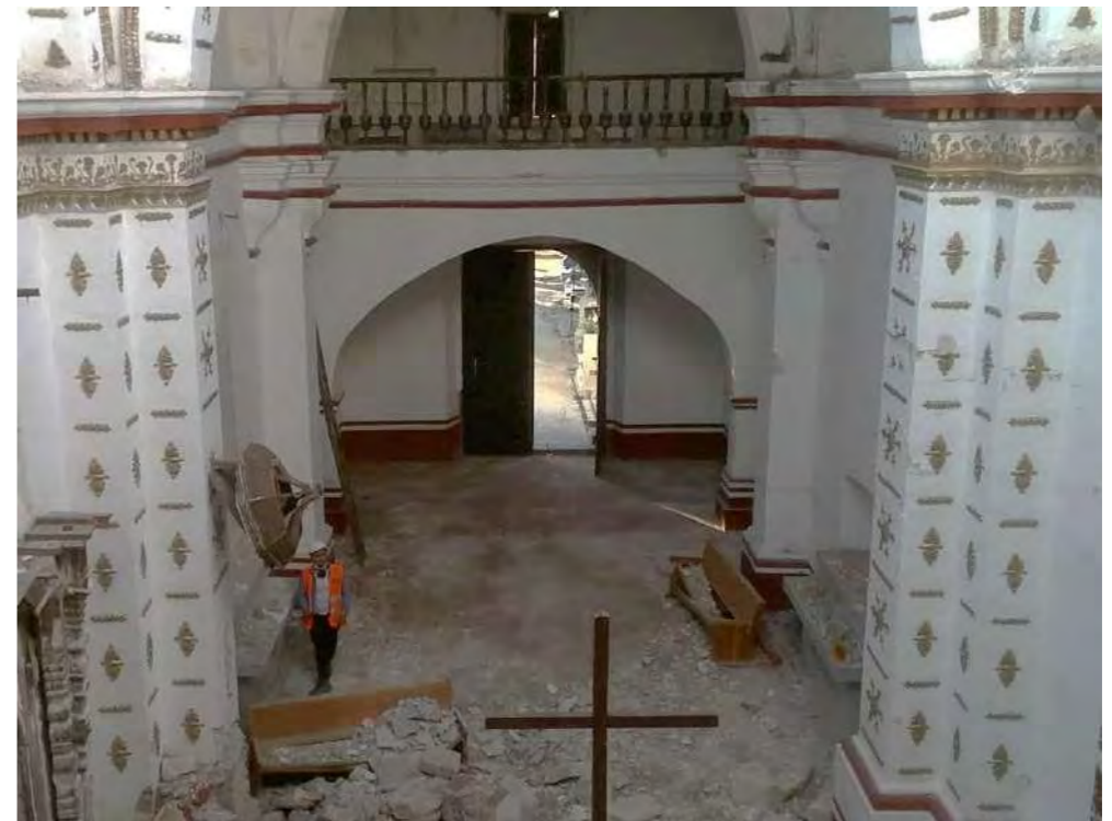
Imagen. 33. Sotocoro del templo de San Agustín Obispo visto desde el ábside, se alcanza a apreciar la balaustrada en la parte superior que delimita el coro. Fuente: Sánchez Paulino, 2018.
