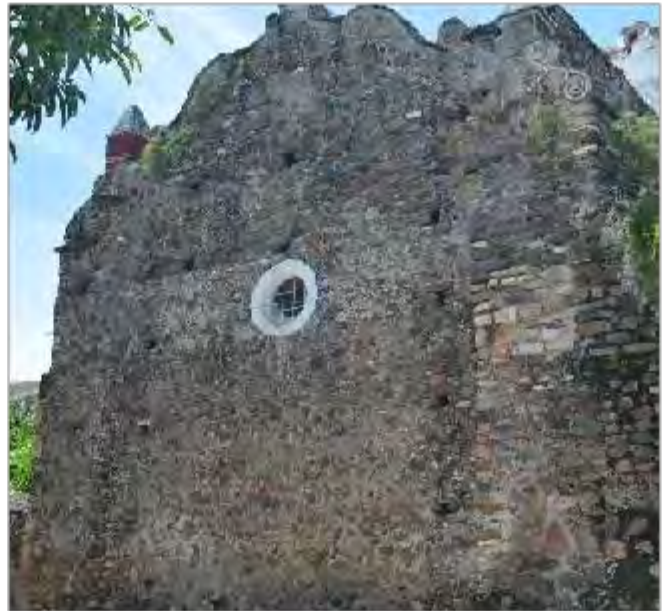
Imagen 3: Muro de fachada Oriente
