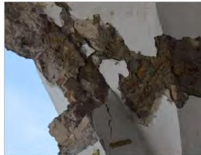
**Imagen 2:** Detalle de afectaciones en arco fajón e intradós de cubierta
