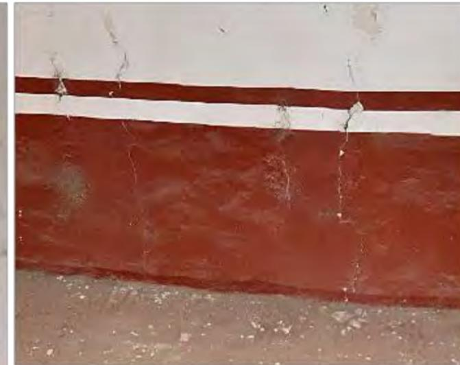
Imagen 2: Detalle de afectaciones en parte baja de muro interior norte
