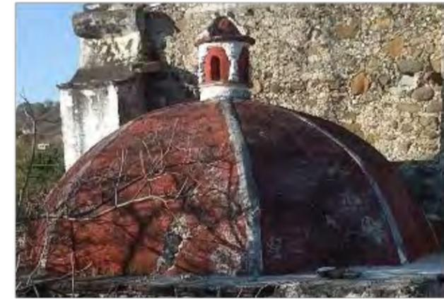
**Imagen 3:** Detalle de fractura en extradós de cúpula vista sur
