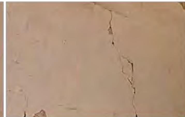
**Imagen 3:** Detalle de afectaciones presentes en parte alta de muro interior norte
