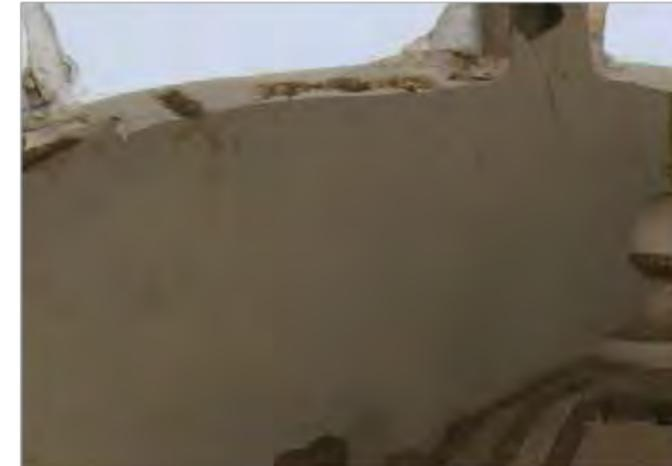
**Imagen 3:** Detalle de fisuras y agrietamientos en muro interior oriente
