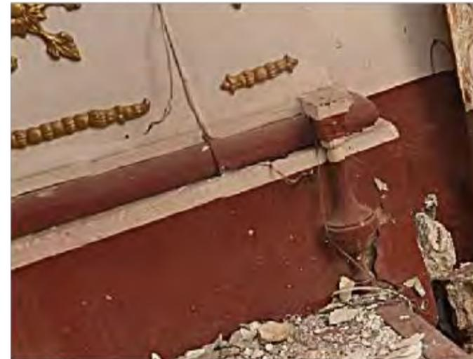
**Imagen 3:** Vista frontal de basa de pilastra suroriente en Nave tramo 2
