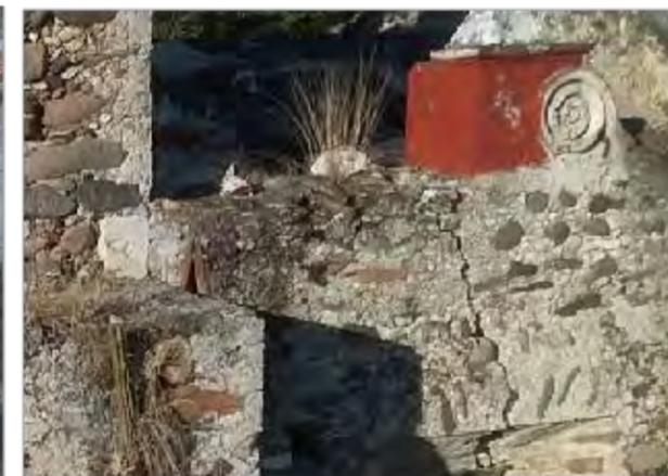
**Imagen 2:** Detalle de afectaciones presentes en pretil de cubierta
