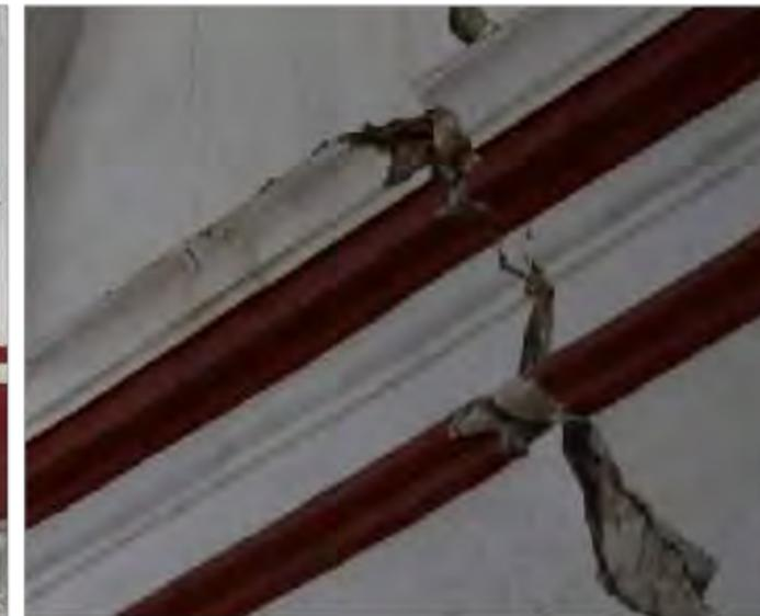
**Imagen 3:** Detalle de afectaciones presentes en juego de molduras en muro interior sur
