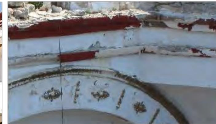
**Imagen 3:** Detalle de afectaciones en molduras superiores de muro interior norte en Nave tramo 2
