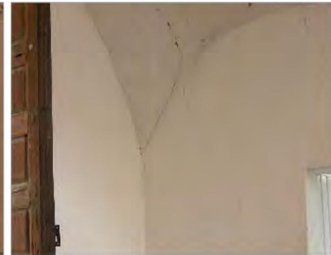
**Imagen 3:** Detalle de afectaciones en parte alta de muro interior norte
