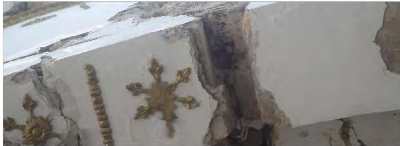
**Imagen 2:** Detalle de afectaciones en intradós de arco fajón oriente de Nave tramo 2
