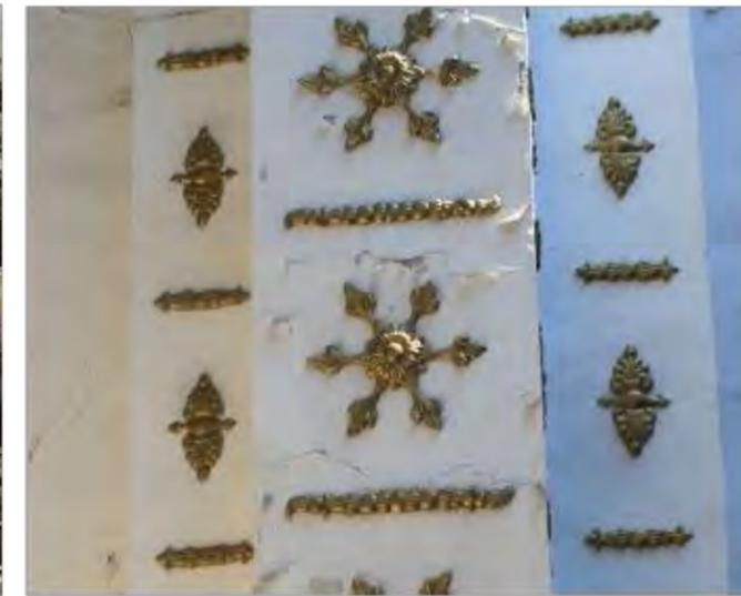
**Imagen 2:** Detalle de afectaciones presentes en fuste de pilastra nororiente
