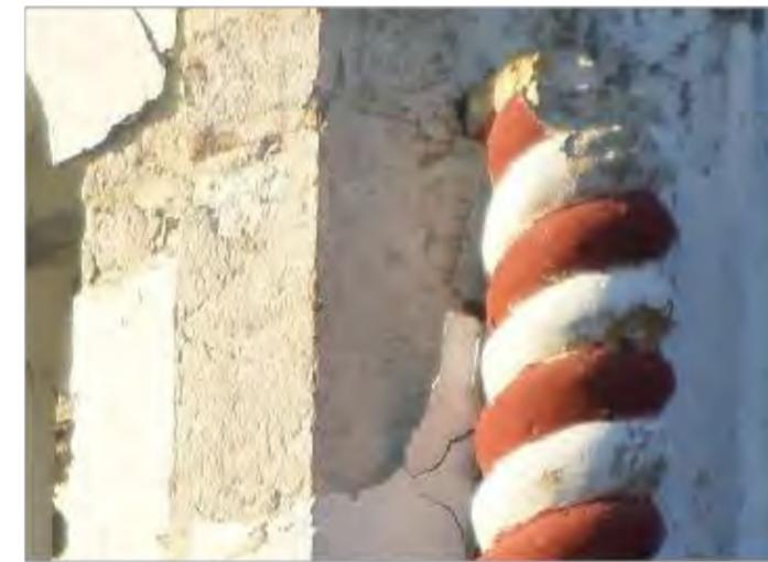
**Imagen 3:** Desprendimiento de aplanados y colapsos parciales en torre campanario fachada sur
