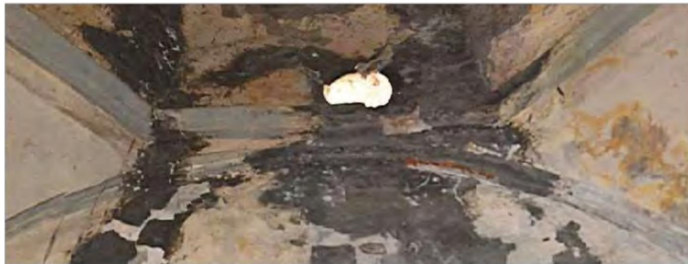
**Imagen 2:** Estado actual de parte alta de muro interior oriente y unión con tambor de cúpula
