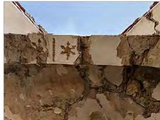
**Imagen 2:** Detalle de afectaciones en intrados de arco Oriente
