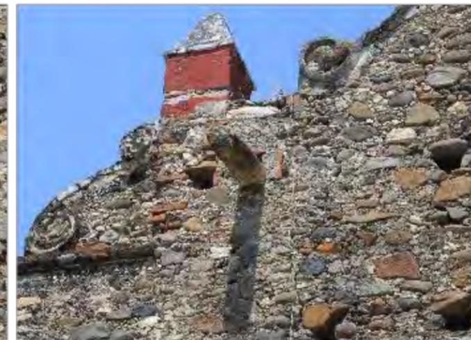
**Imagen 4:** Detalle de agrietamientos presentes en elementos de remate del muro exterior oriente
