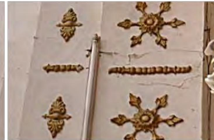
**Imagen 3:** Detalle de afectaciones presentes en fuste de pilastra nororiente en Nave tramo 2
