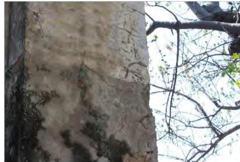
**Imagen 2:** Detalle de fisuras en muro exterior poniente
