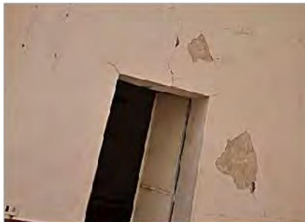
**Imagen 2:** Detalle de afectaciones presentes en parte baja de muro interior norte
