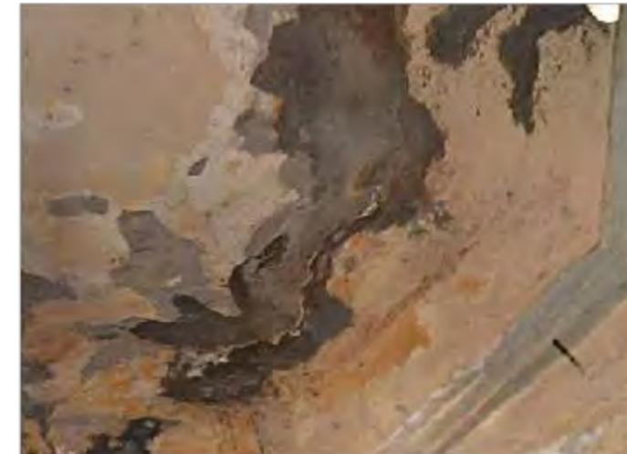
**Imagen 2:** Vista del desprendimiento de aplanados existentes en intradós de cúpula
