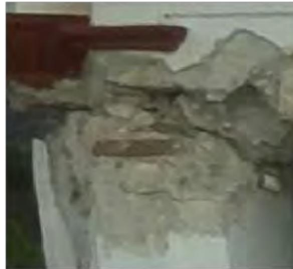
**Imagen 2:** Detalle de agrietamientos en segundo cuerpo de torre campanario
