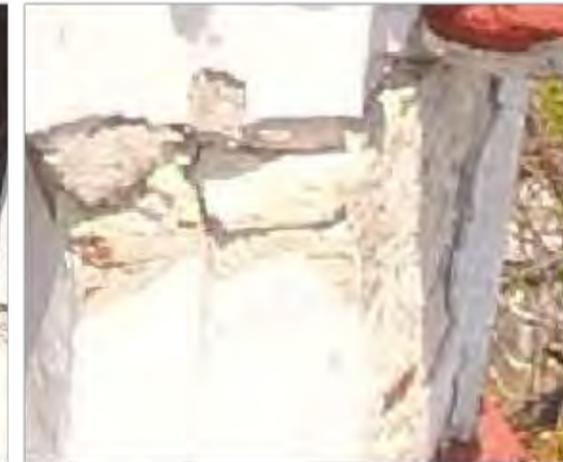
**Imagen 3:** Detalle de los agrietamientos perimetrales en segundo cuerpo de torre, fachada oriente
