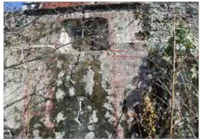
**Imagen 2:** Vista de los agrietamientos y humedades en muro exterior sur
