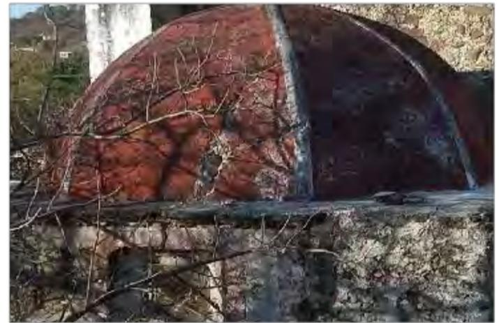
**Imagen 1:** Fracturas y agrietamientos en cúpula vista exterior sur
