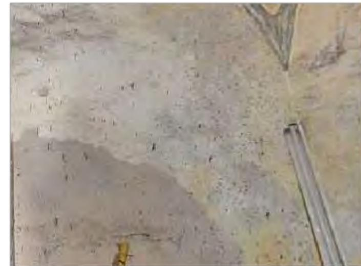
**Imagen 4:** Humedades existentes en muro interior norte
