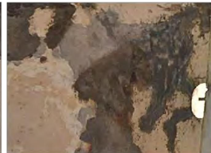
**Imagen 4:** Detalle de deterioros en intradós de cúpula
