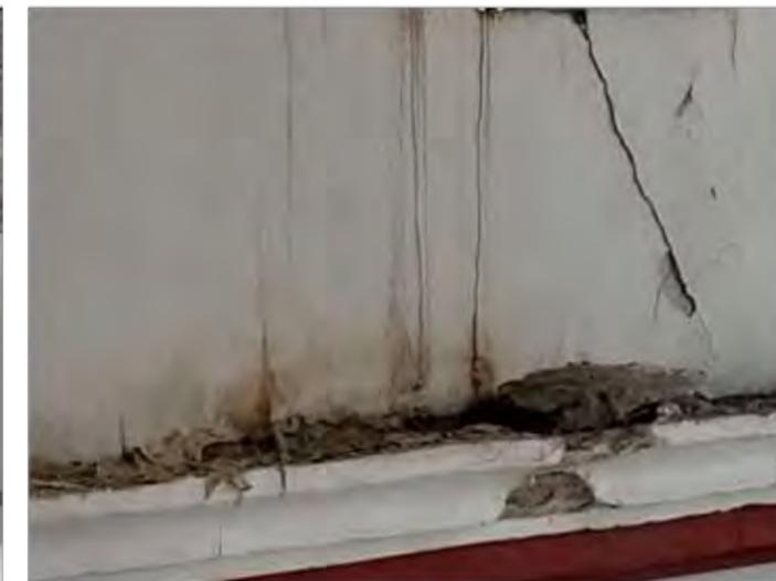
**Imagen 3:** Detalle de afectaciones presentes en cornisamento en muro interior norte
