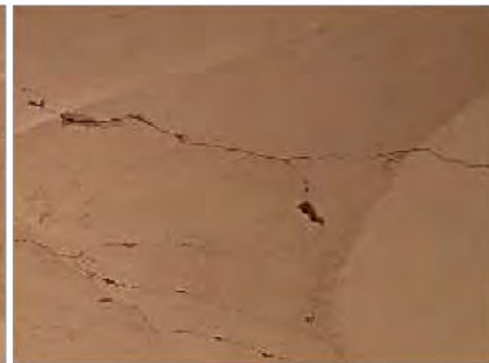
**Imagen 3:** Detalle de afectaciones en intradós de cubierta
