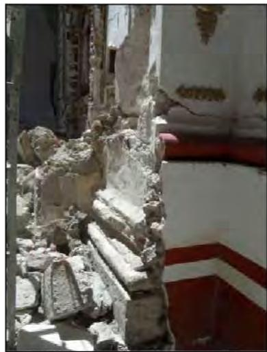
F02. Detalle de afectaciones en pilastra interior sur de Nave tramo 1
