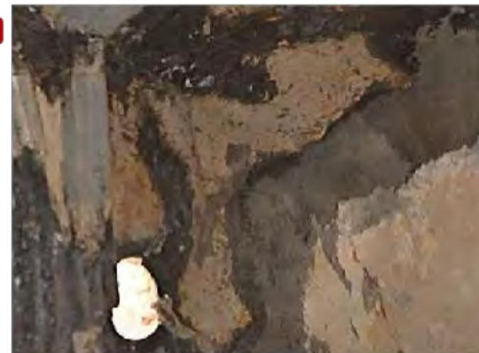
**Imagen 3:** Agrietamientos y recubrimientos en mal estado en intradós de cúpula
