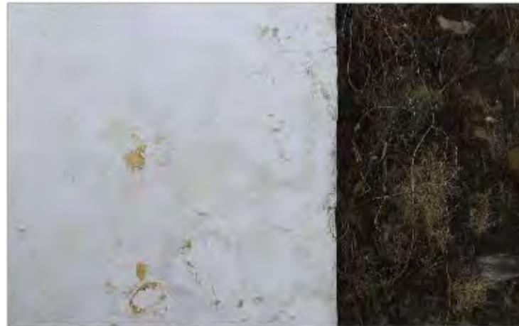
Imagen 3: Detalle de vegetación parásita presente en muro exterior poniente
