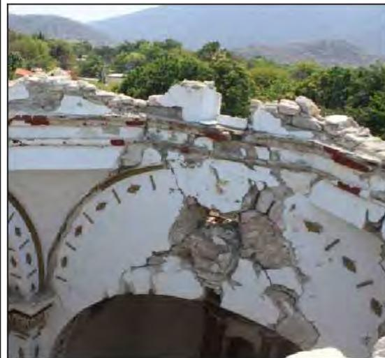
F01. Detalle de deterioros en muro y arco fajón de Presbiterio
