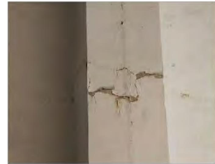
Imagen 3: Detalle de afectación presente en fuste de pilastra nororiente
