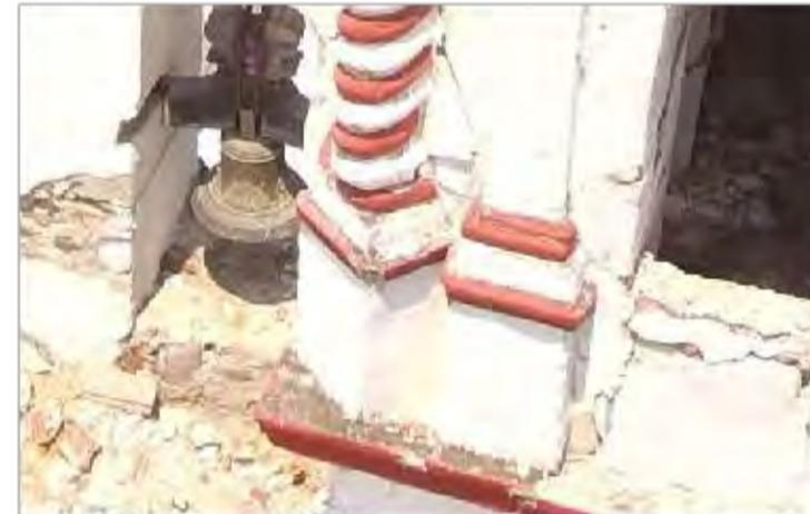
**Imagen 2:** Detalle de afectaciones presentes en parte baja de segundo cuerpo de torre fachada oriente
