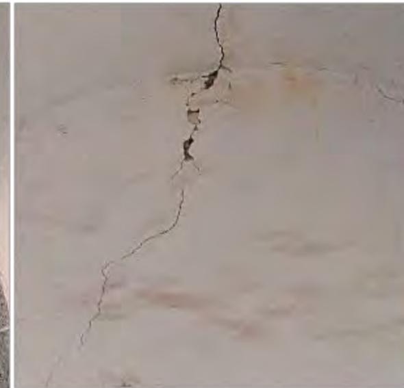
Imagen 2: Detalle de agrietamientos en parte alta de muro interior sur
