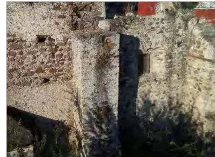
**Imagen 2:** Vista de afectaciones en segundo cuerpo de contrafuerte
