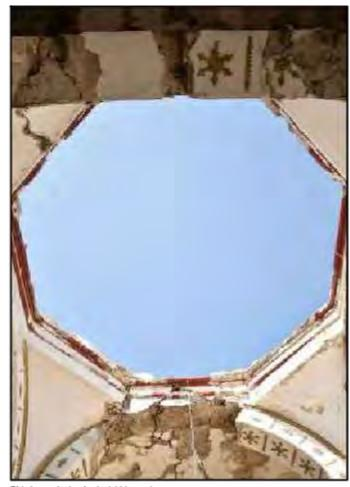
F01. Ausencia de cúpula debido a colapso
