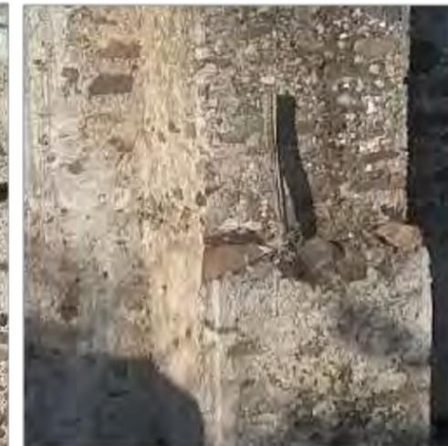
**Imagen 2:** Detalle de vegetación parásita presente en contrafuerte suroriente
