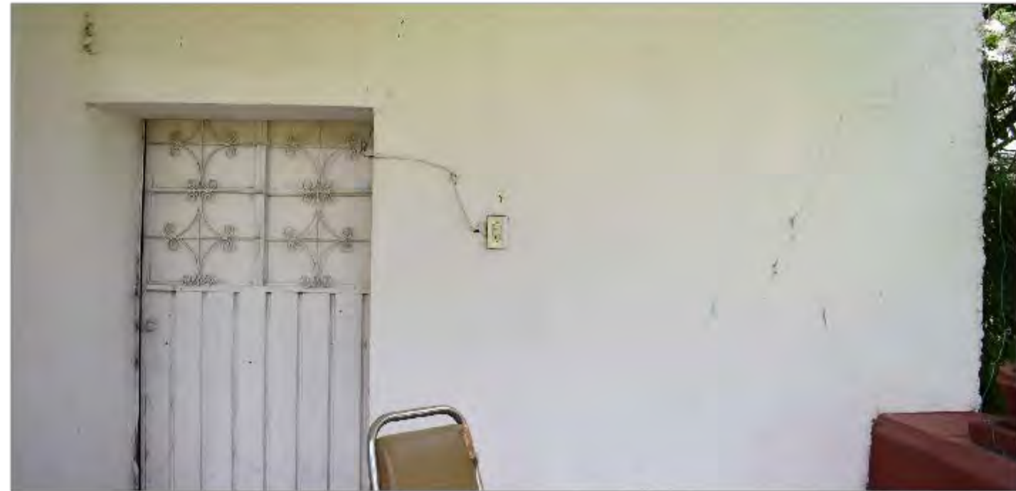
Imagen 1: Vista general de muro exterior norte
