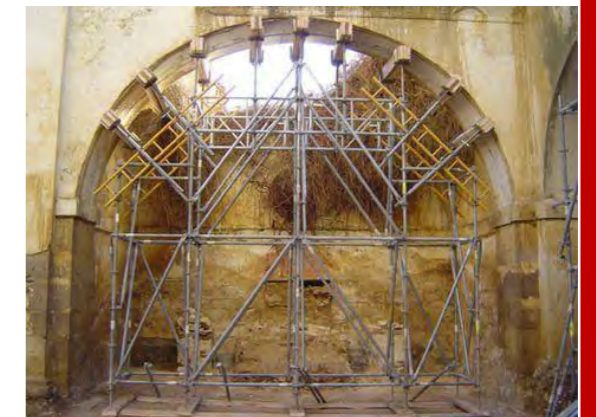
Fig. 3: Ejemplo de apuntalamiento con acero en arco
