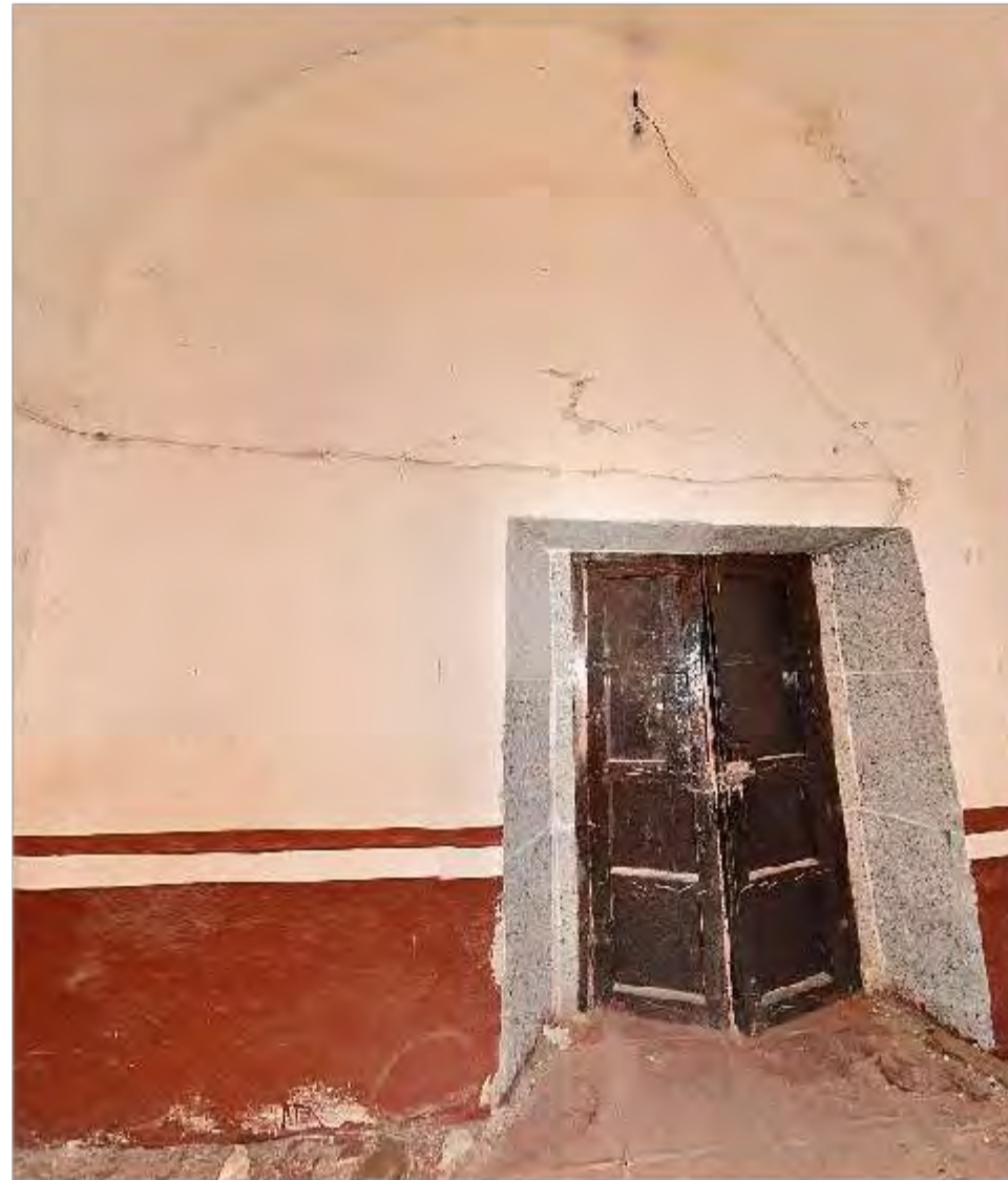
Imagen 1: Vista general de muro interior norte
