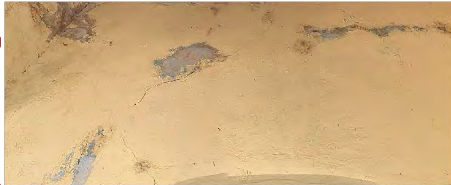
Imagen 1: Vista general del muro interior sur
