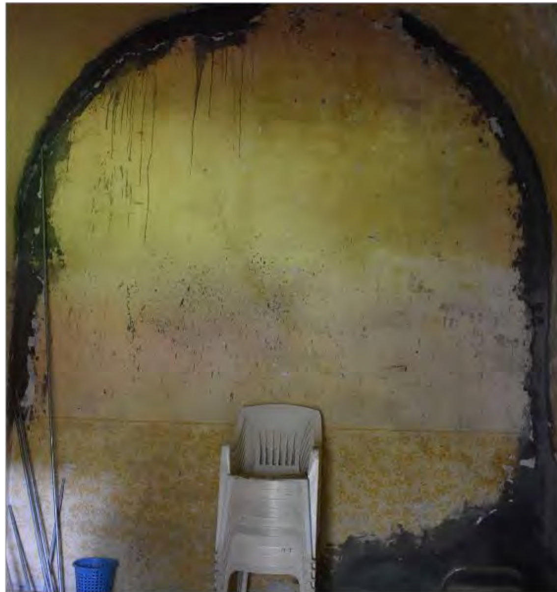
Imagen 1: Vista general de muro interior sur
