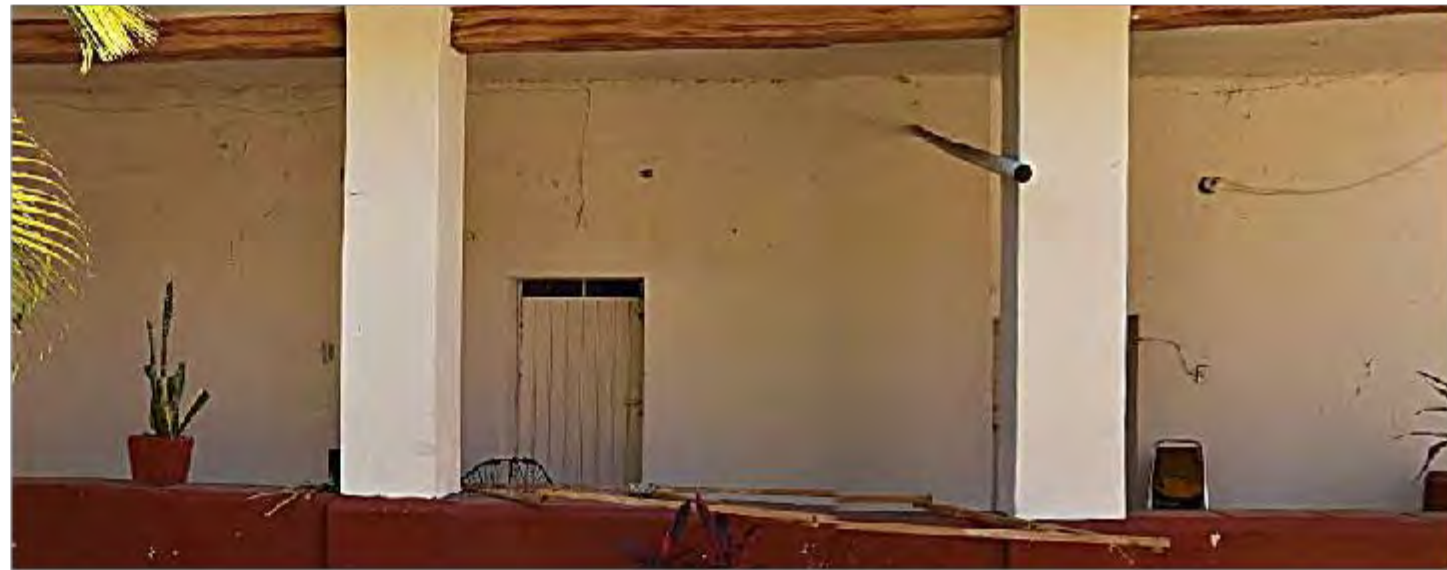
Imagen 1: Vista general de muro exterior norte
