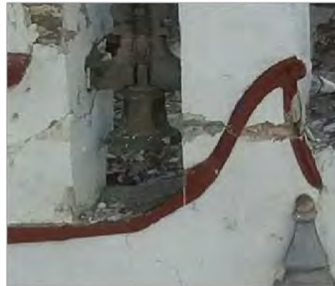
Imagen 1: Detalle de agrietamientos en espadaña
