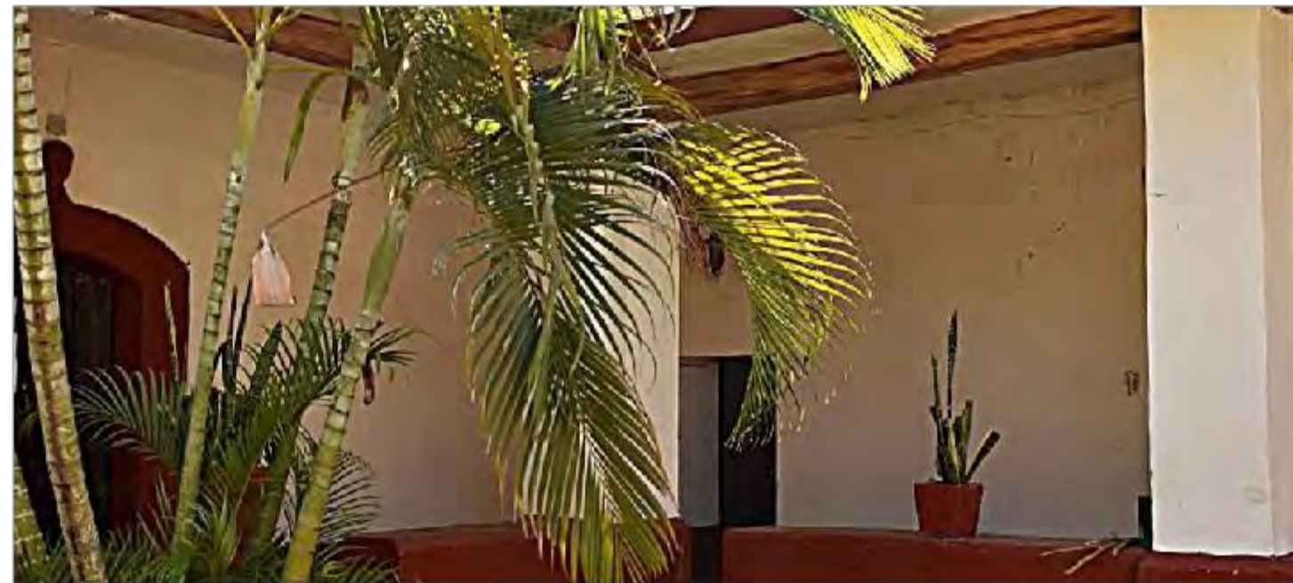
Imagen 1: Vista general del muro exterior norte
