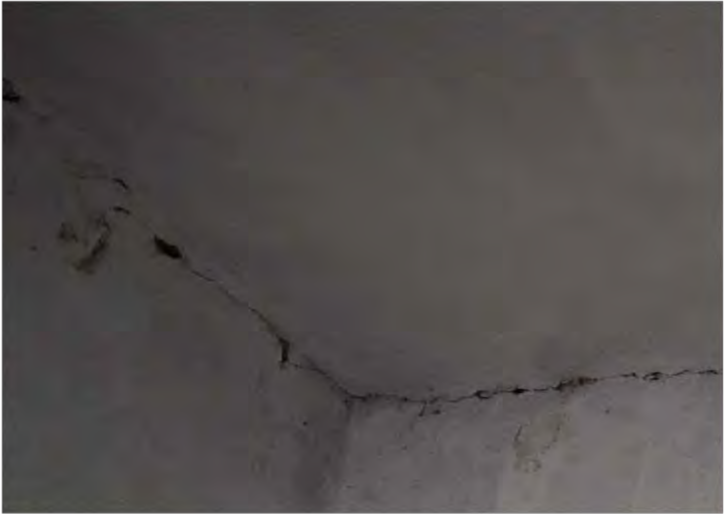
Imagen 1: Vista general del intradós de cubierta
