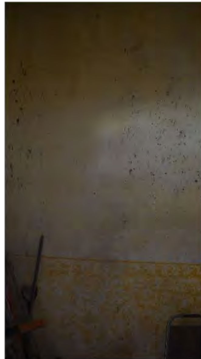
Imagen 1: Vista del muro interior oriente
