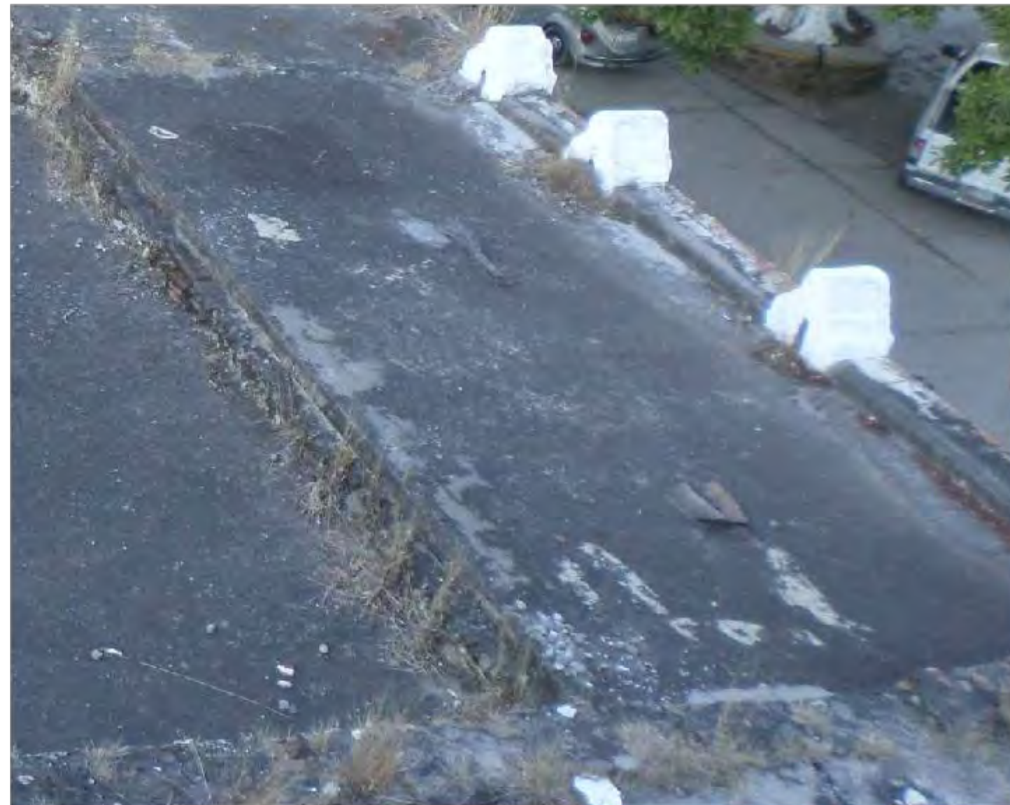
Imagen 1: Vista del extradós de cubierta
