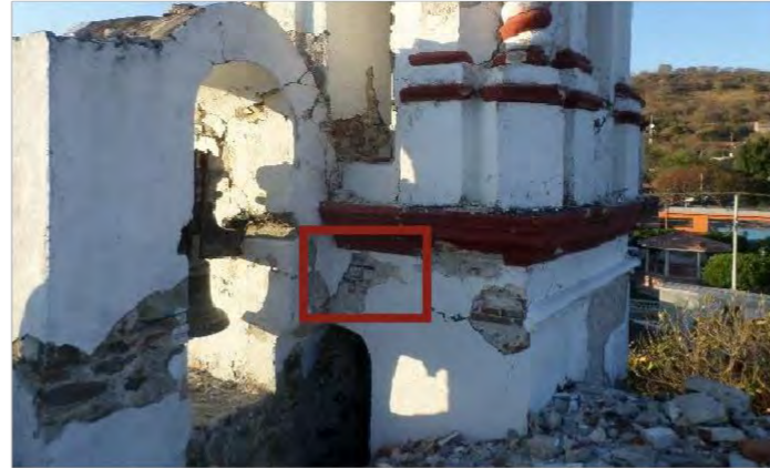
Imagen 1: Varilla de acero corrugada localizada en el lado sur del segundo cuerpo de torre campanario, muestra avanzado estado de oxidación
