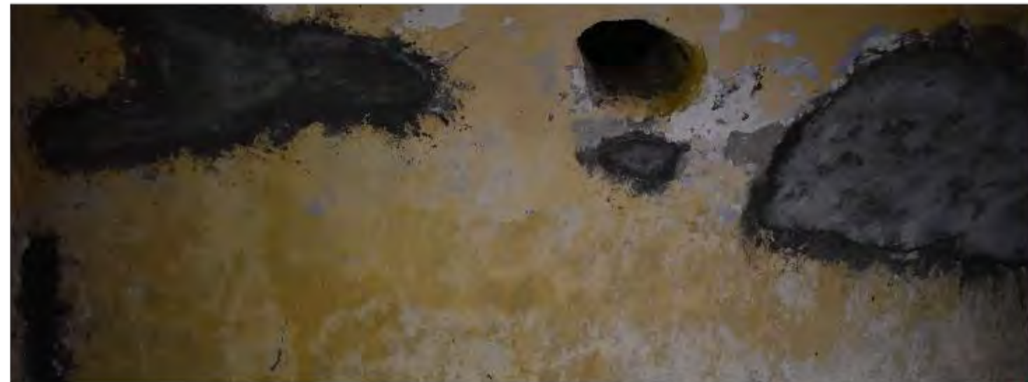
Imagen 2: Vista del intradós de la cubierta
