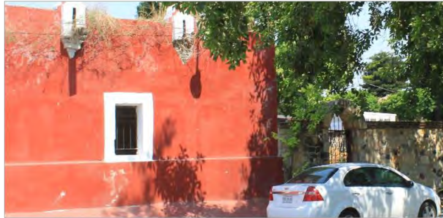
Imagen 1: Vista general de muro exterior oriente
