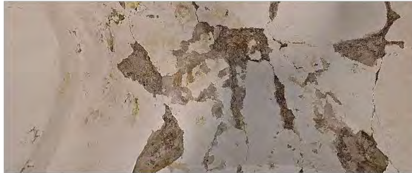
Imagen 1: Vista general de afectaciones presentes en intradós de bóveda de Coro parte norponiente
