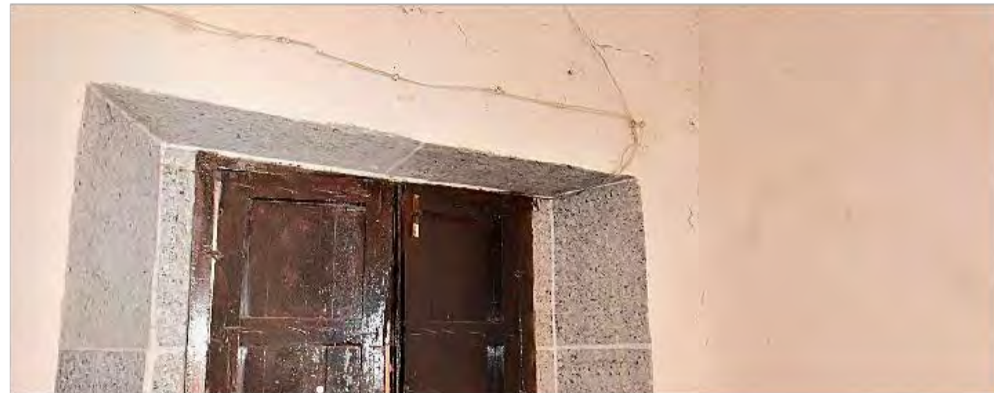
Imagen 2: Detalle de parte del muro interior norte
