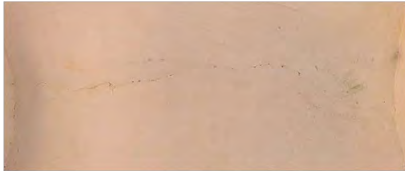
Imagen 1: Vista general de intradós de bóveda
