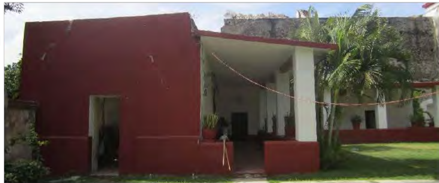
Imagen 1: Vista general de muro exterior norte
