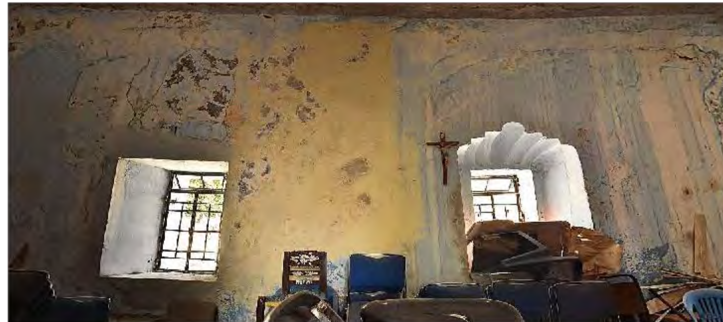
Imagen 1: Vista general del muro interior oriente
