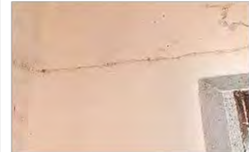
Imagen 3: Detalle del estado actual de muro interior norte
