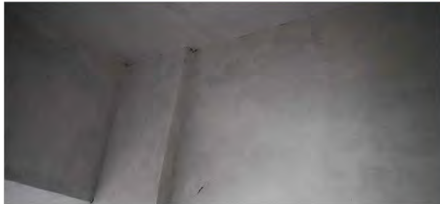
Imagen 1: Vista general del muro interior oriente
