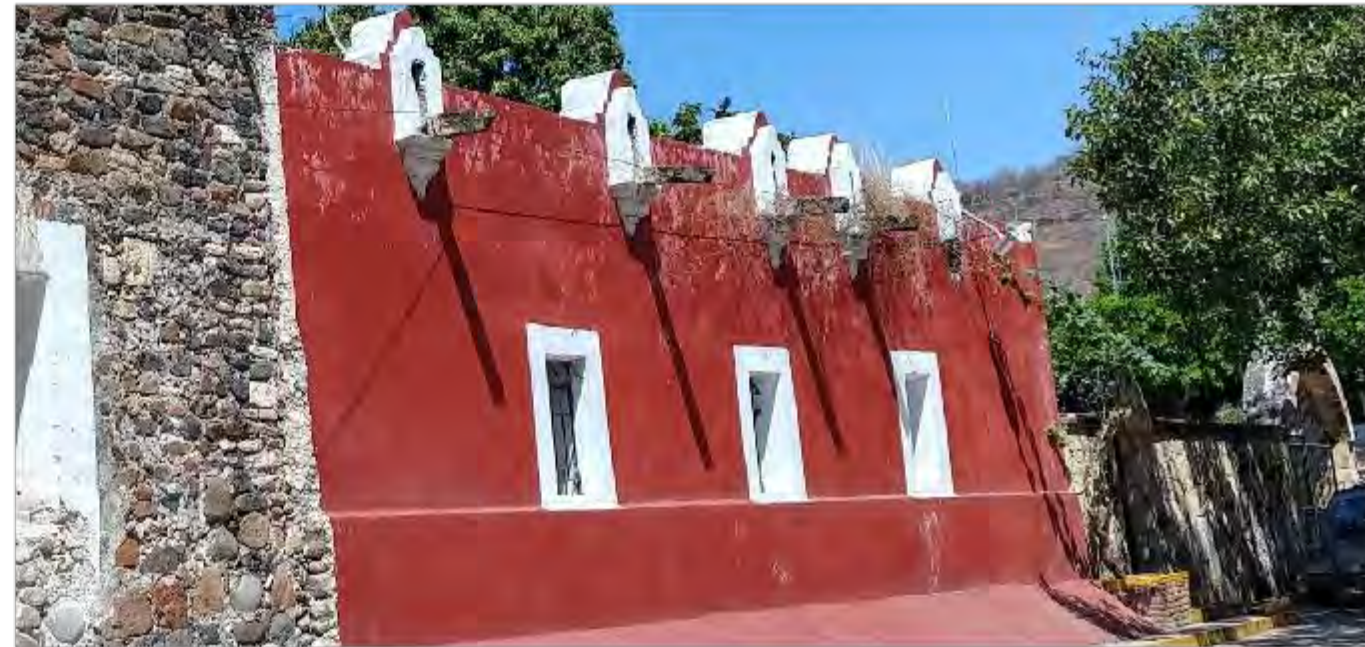
Imagen 1: Vista en perspectiva del muro exterior oriente
