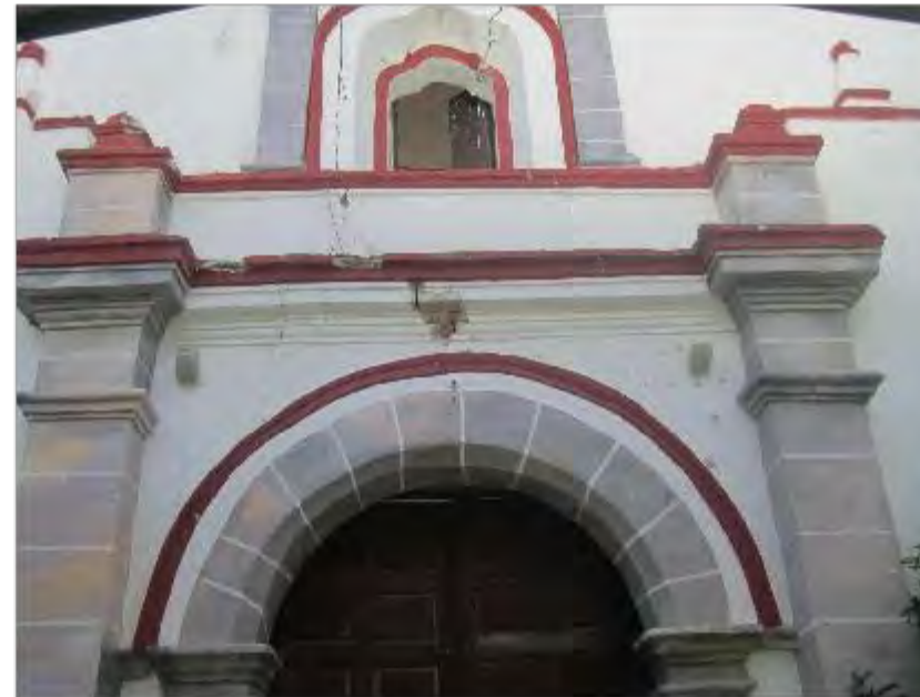
Imagen 1: Vista general de portada de acceso al templo
