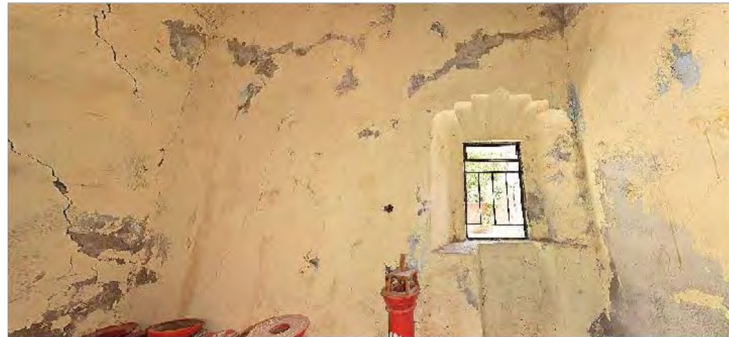
Imagen 1: Vista general del muro interior norte
