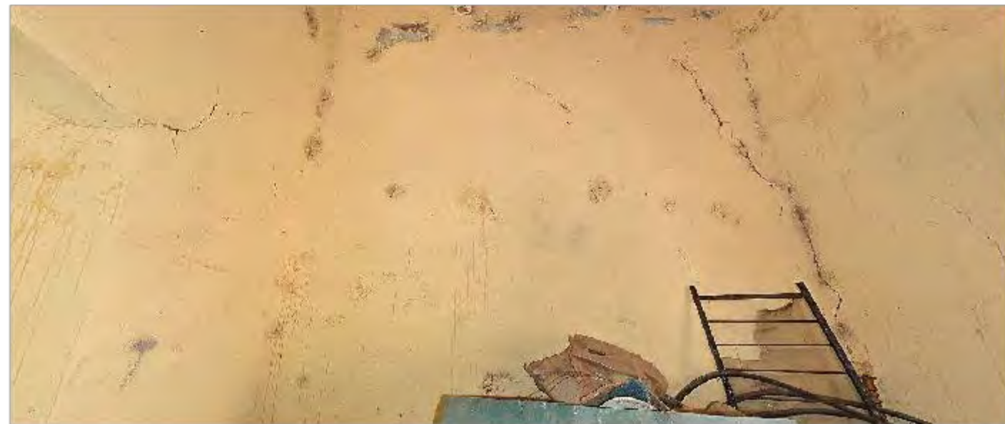
Imagen 1: Vista del muro interior poniente
