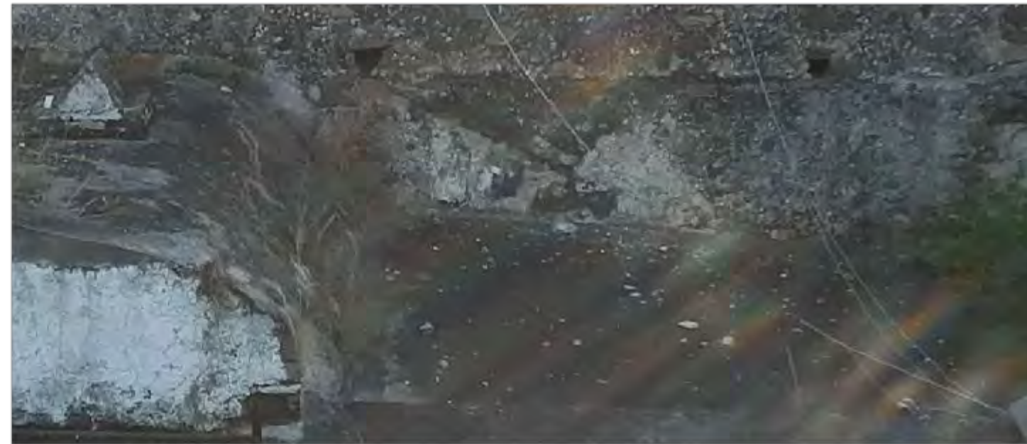
Imagen 1: Vista general de la azotea
