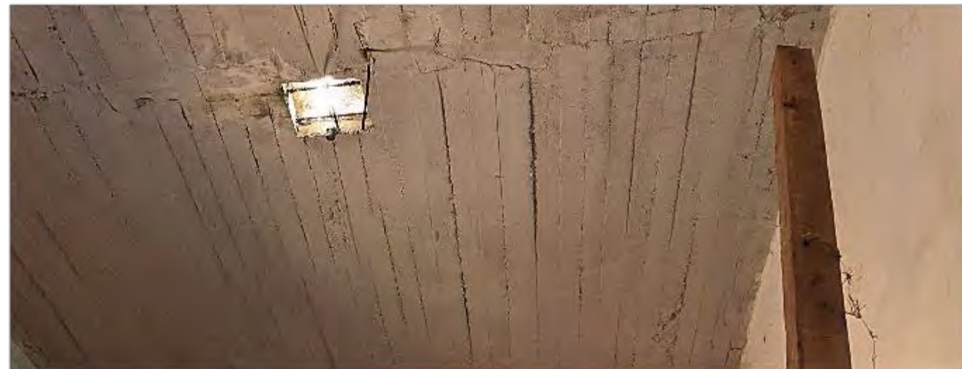
Imagen 2: Vista por intradós de cubierta
