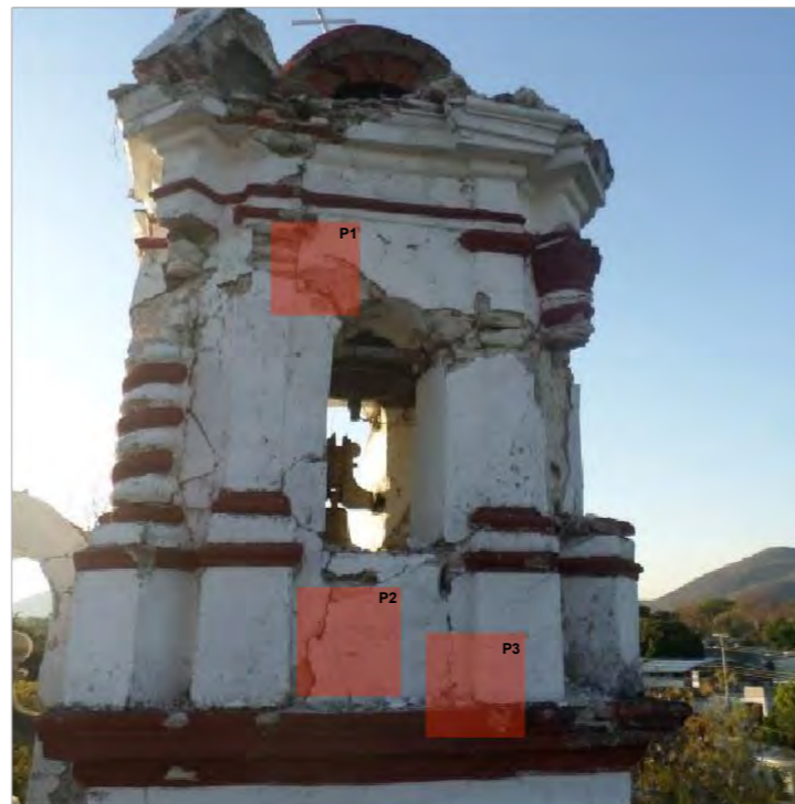
Imagen 2: Puertos de inyección localizados en el lado oriente del segundo cuerpo de torre campanario
