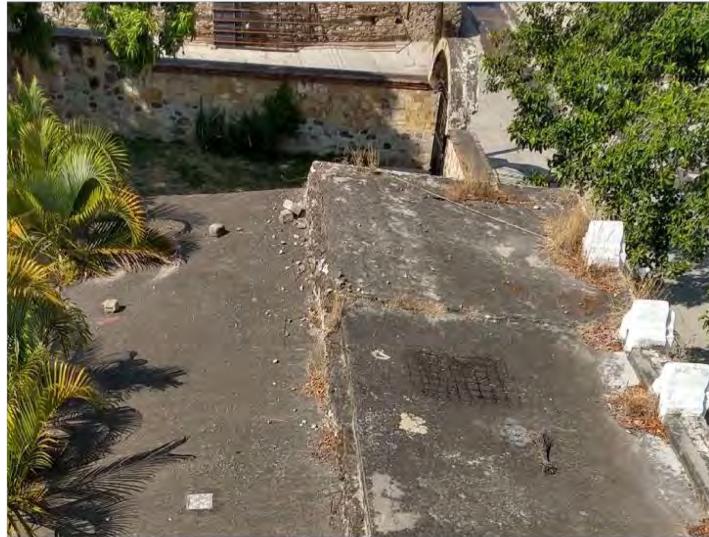
Imagen 1: Vista general de la azotea
