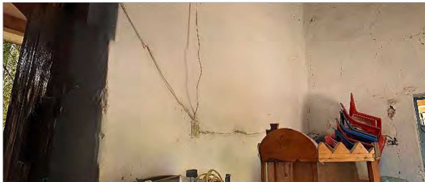
Imagen 2: Vista del estado actual del muro interior poniente
