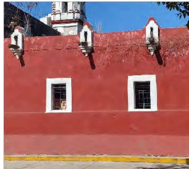
Imagen 1: Vista frontal del muro exterior oriente
