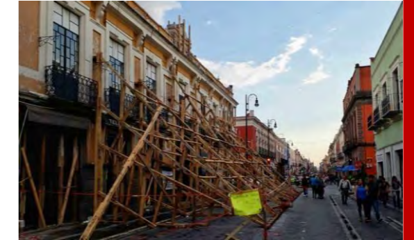
Fig. 2: Ejemplo de apuntalamiento con madera en muros
