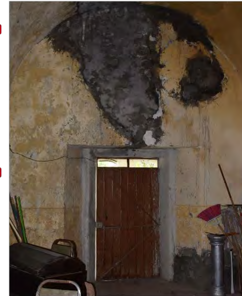
Imagen 1: Vista general del muro interior norte
