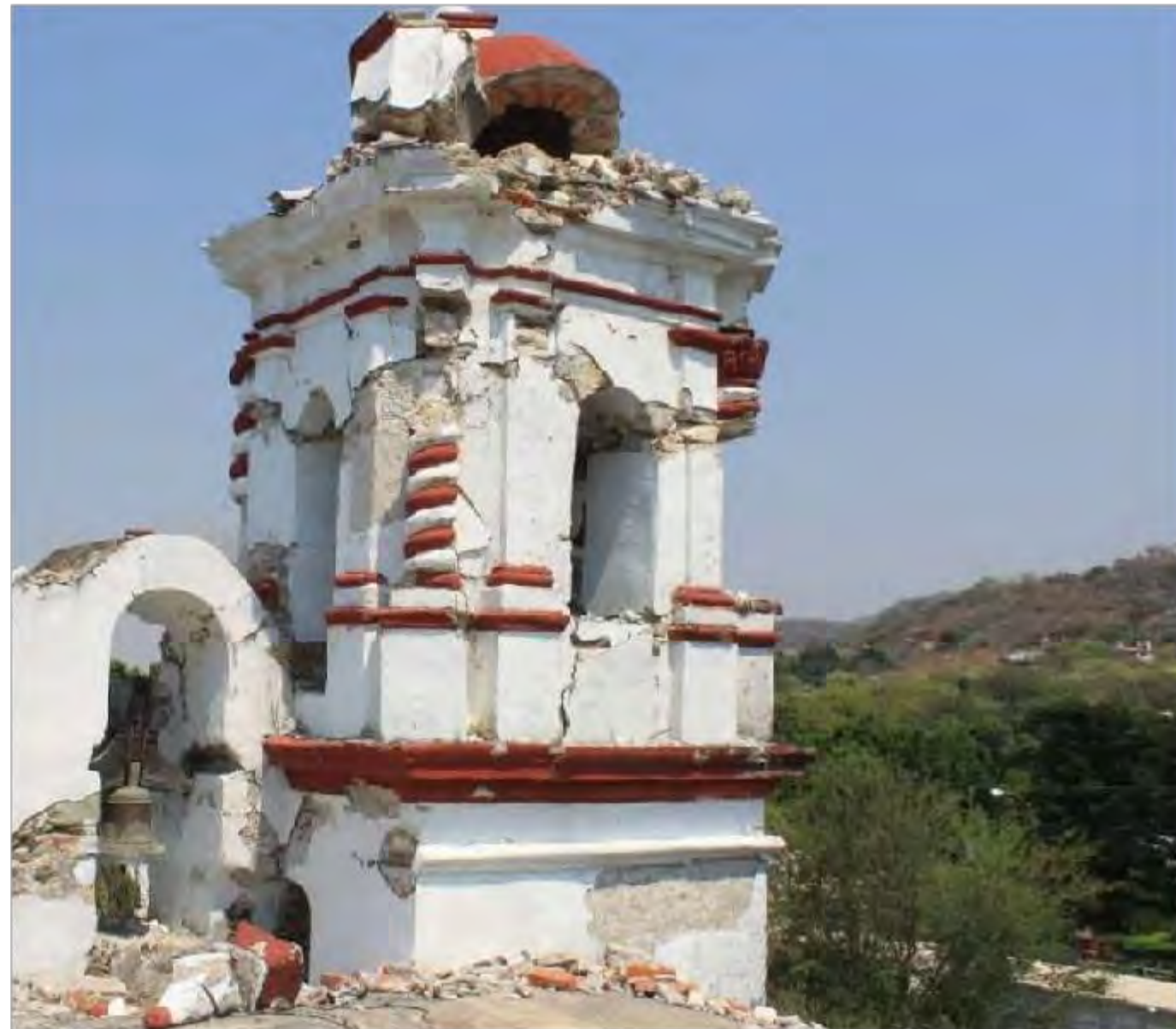
Imagen 1: Vista general desde azotea de torre fachada poniente
