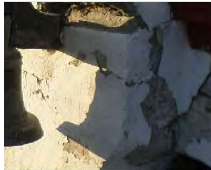
Imagen 1: Detalle de desprendimientos en base de espadaña vista oriente
