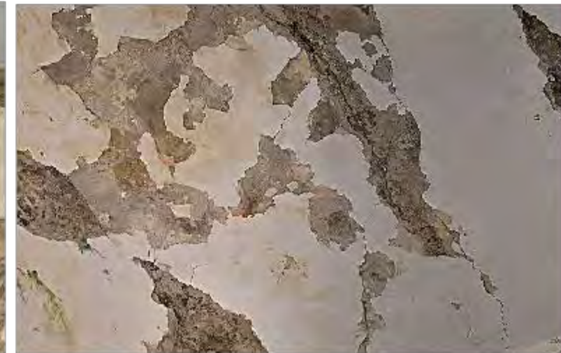
Imagen 2: Vista por intradós de bóveda de Coro
