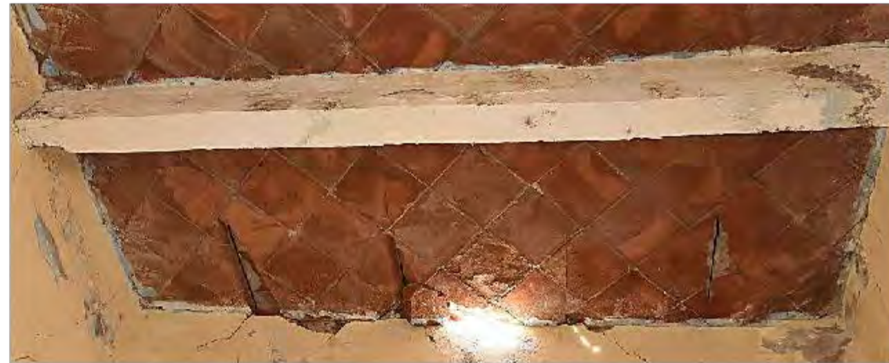
Imagen 1: Sección del intradós de cubierta
