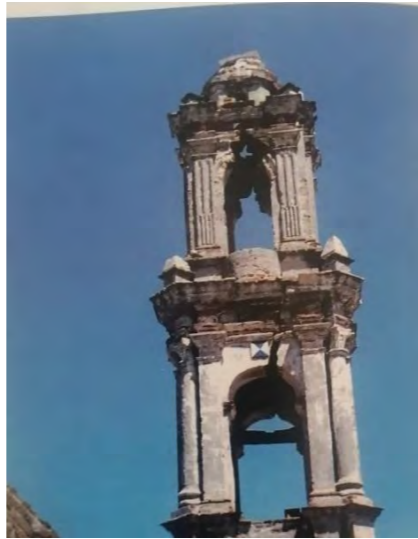
Imagen 3. Torre del templo de San José, Puebla Pue. Fuente: INAH, 2002.
