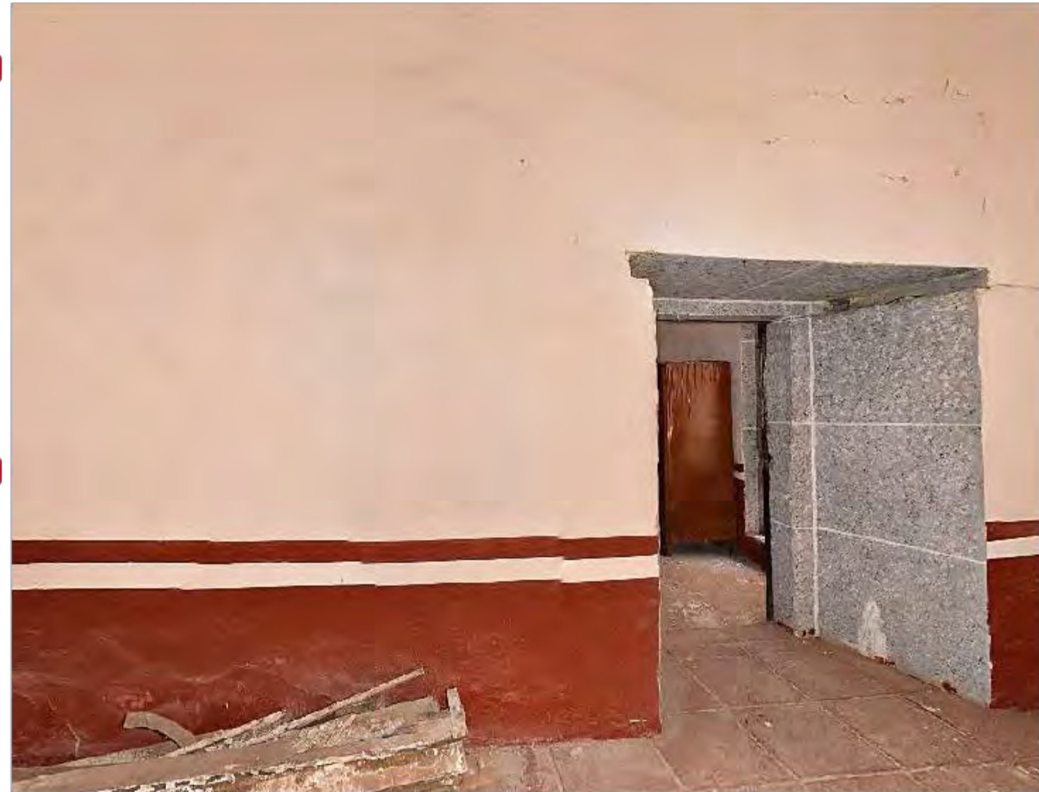
Imagen 1: Vista general de muro interior oriente
