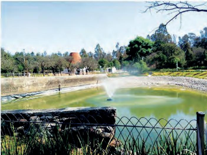
Un Jagüey es un depósito artificial de aguas, construidos mediante excavaciones y conformación de diques o terraplenes, por ganaderos como abrevaderos para los animales.
