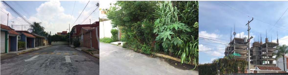
Figuras 13 - 15. Tipología de vivienda residencial, de autoconstrucción y proceso de gentrificación en la colonia Las Lajas.
