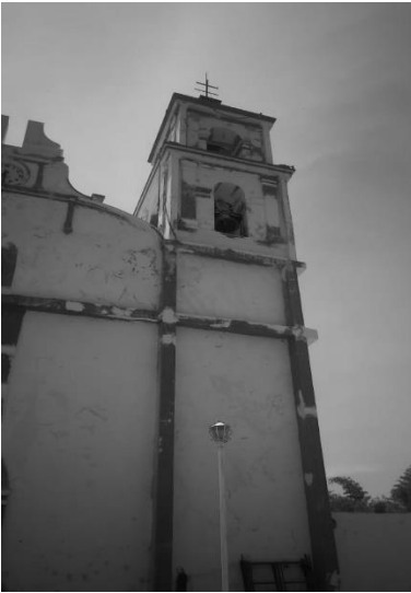
Figura 2.59. Torre campanario de San Andrés Ahuatelco. 2019. Autor: Daniel Sánchez. (2017)
