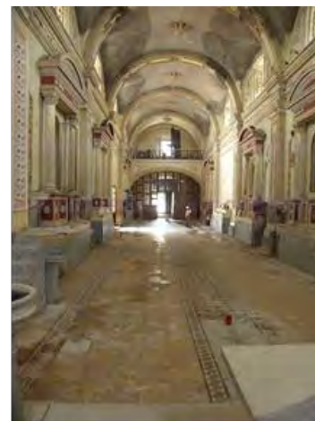
Figura 3.106. Depósitos de humedad en el templo de Santo Tomás, Tlapanalá. Autor: Daniel Sánchez. (2018)
