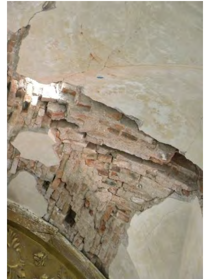
Figura 3.78. Bóveda de tabique rojo recocido del templo de San Felipe. Autor: Daniel Sánchez. (2018)
