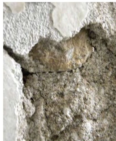
Figura 3.103. Detalle empleo de piedra de canto rodado, en la fábrica de muros. Autor: Daniel Sánchez. (2018)
