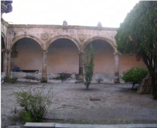
Figura 2.33. - Claustro del Convento de la Purificación de la Virgen, Tepapayeca. Recuperado de INAH.
