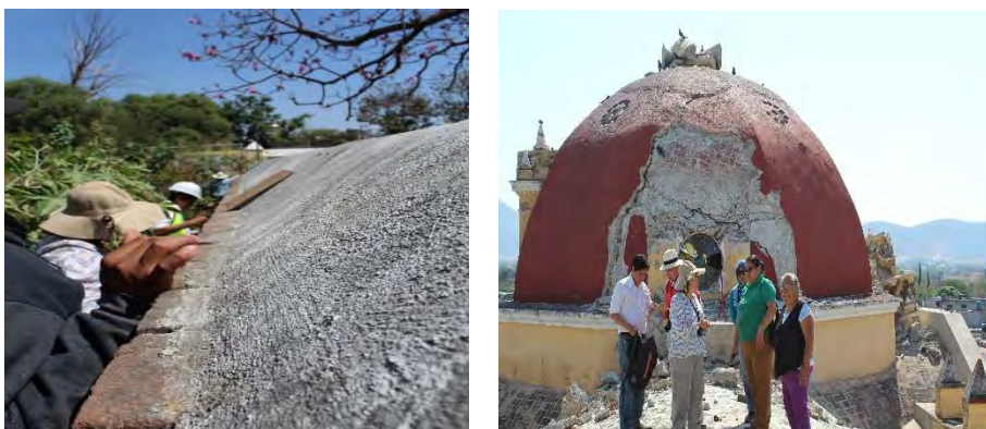
Figura 3.21-3.22. Levantamiento arquitectónico con apoyo de la comunidad. La imagen derecha corresponde al levantamiento arquitectónico del templo de Santo Domingo Ayotlicha, donde la comunidad participa, en la toma de medidas, y dimensionamiento del conjunto. La fotografía izquierda, corresponde al levantamiento y registro de afectaciones en la cúpula del templo de Santo Tomás, en Tlapanalá, donde se ha hecho participe a la población. Autor: Daniel Sánchez. (2018)
