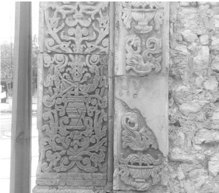
Figura 2.47. (2018). Detalle Arcada del Ex Convento de San Miguel Arcángel. Autor: Daniel Sánchez. (2019)
