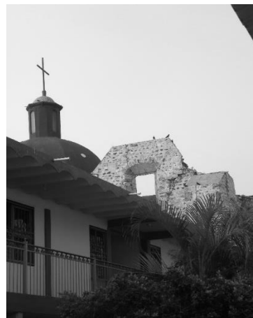
Figura 2.60. Diferencias de altura, entre el paramento norte, y la actual altura de la bóveda, en el templo Parroquial de San Cristóbal, Tepeojuma. Autor: Daniel Sánchez. (2018)
