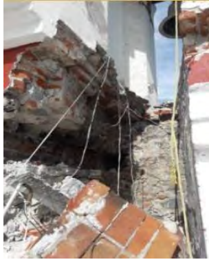
Figura 3.99. Detalle composición de muro en el templo de la Virgen de Ocotlán, Tepexco. Autor: Daniel Sánchez. (2018)
