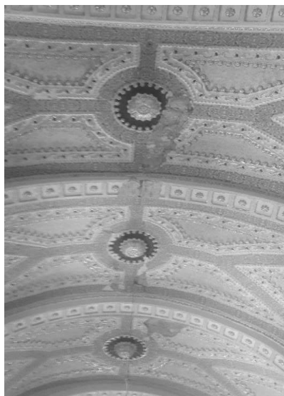
Figura 2.139. Detalle de la bóveda y pinjantes del templo de Santo Domingo, Huehuetlán. Autor: Daniel Sánchez. (2018)
