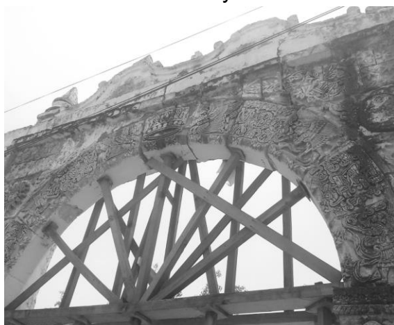
Figura 2.49. Detalle clave y dovelas Arcada del Ex Convento de San Miguel Arcángel, Tilapa. Autor: Daniel Sánchez. (2017)
