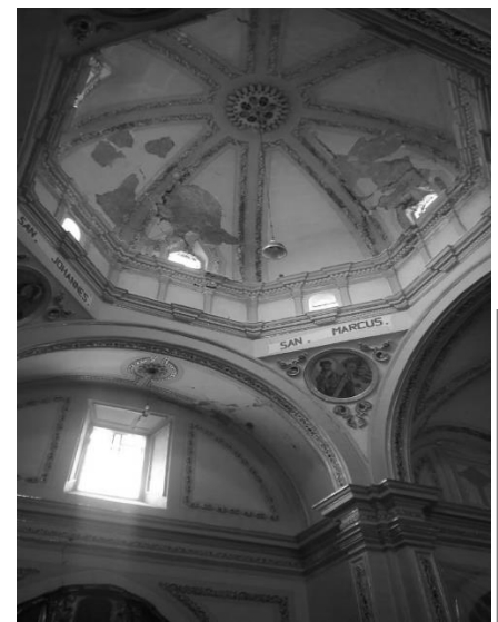
Figura 2.143. Vista interior de la cúpula de Santiago, Apóstol, Teopantlán. Autor: Daniel Sánchez.
