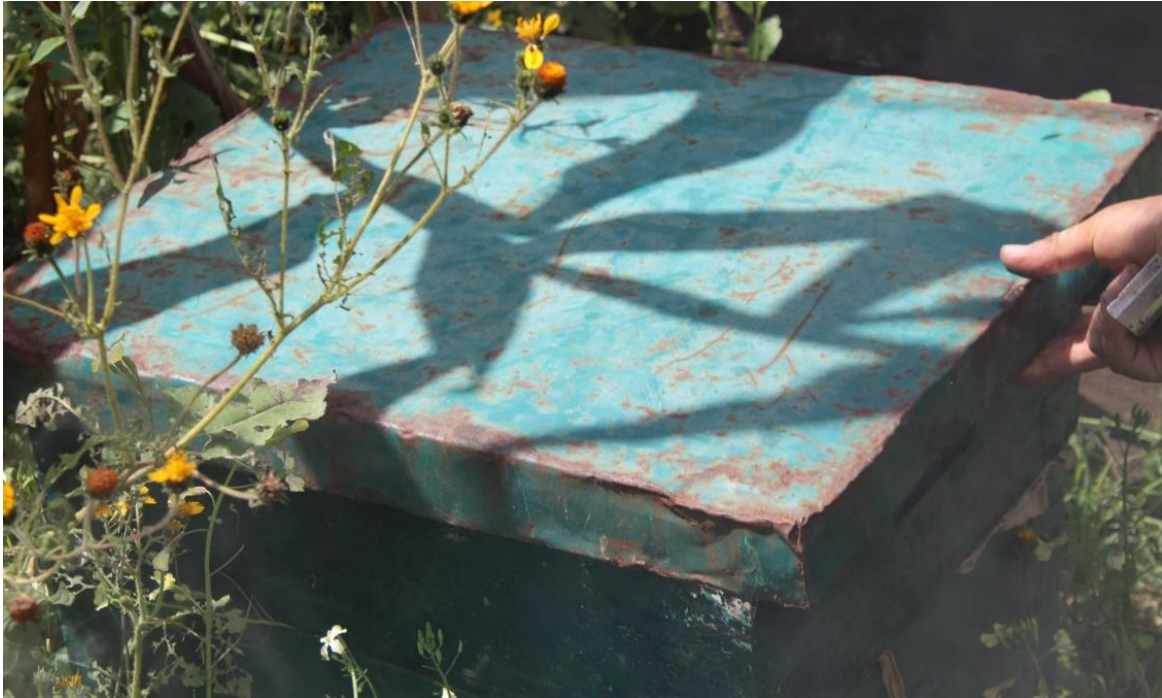
Figura 27. Cubierta de colmena con material en estado de oxidación. Fuente: Elaboración propia, 2020.
