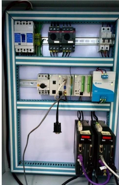
Figura 3.9 Distribución de dispositivos de potencia y control en tablero
