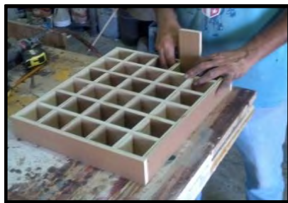
Figura 2. Elaboración de molde para pruebas de Resistencia a la compresión
