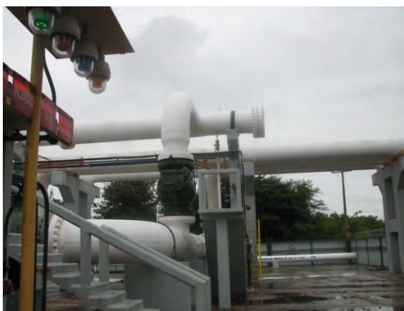
Figura 5. Alarmas Audibles en instalaciones petroleras de la región sur
