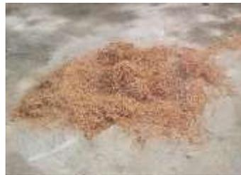
2. Mezcla de elementos. Se mezclan los elementos que se van a utilizar en el acabado, fibra de coco, agua y cemento.
