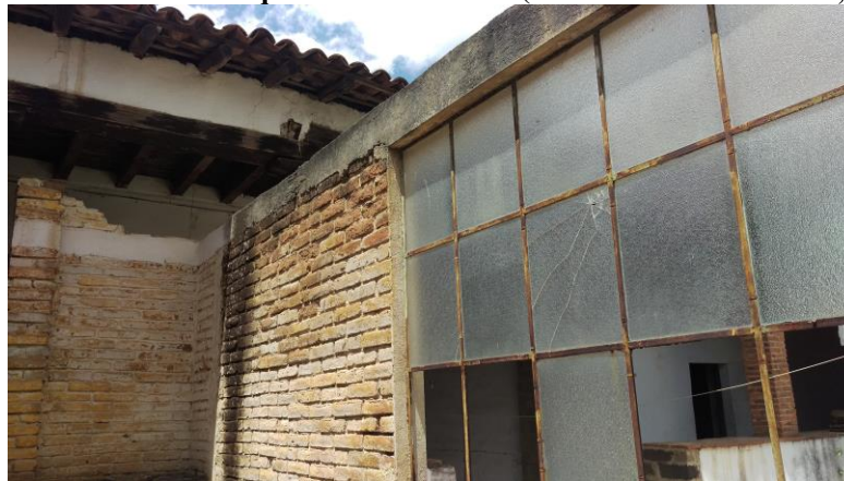
Figura 3. Materiales no afines en la arquitectura vernácula (Casa Cural en Jocotitlán, Estado de México)
