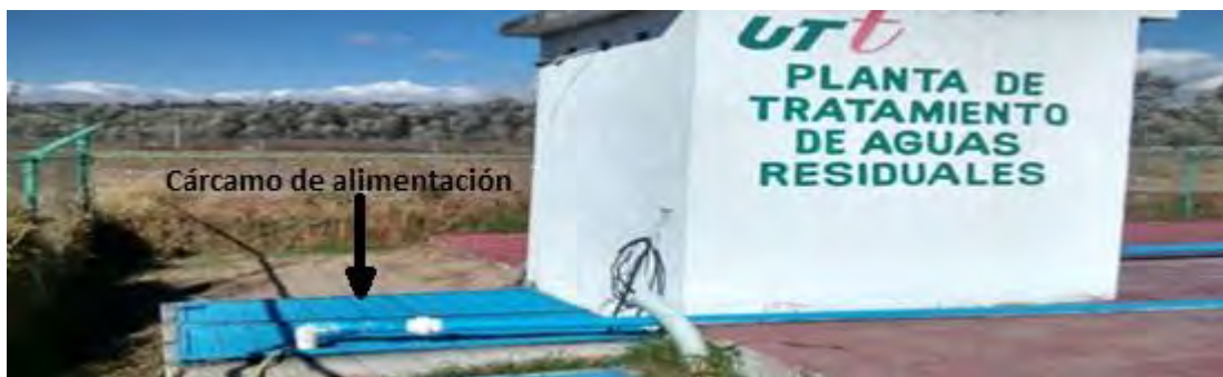
Figura 1: Planta de tratamiento de aguas residuales.
