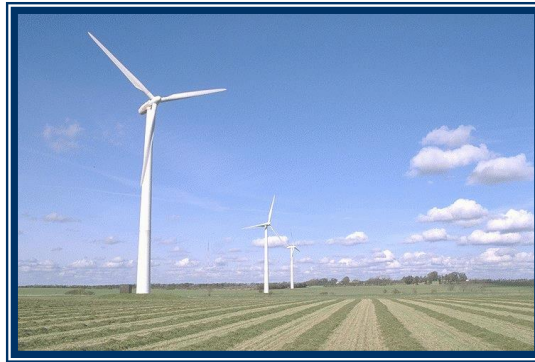
Figura 3 Vista parcial de una central
