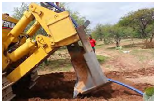
Ilustración 2. Preparación del ripper antes de instalación.
