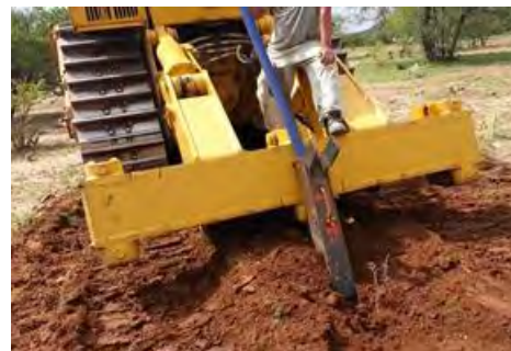
Ilustración 3. Instalación del ducto
