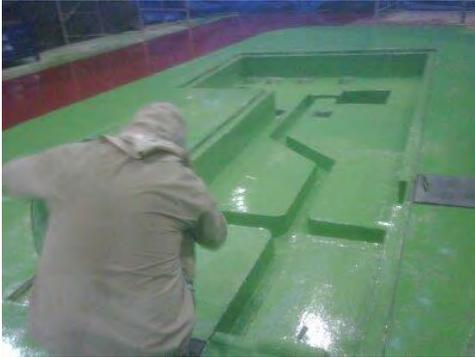
Fotografía 1 Recubrimiento Antiácido
