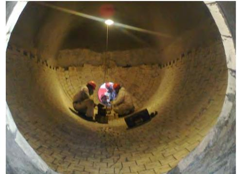
Fotografía 6 Instalación de Ladrillo Refractario
