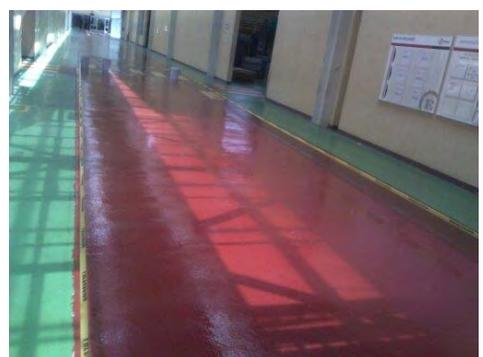
Fotografía 3 Instalación Antiácido en Piso
