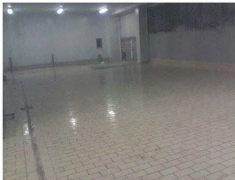
Fotografía 2 Instalación de Loseta en Giro Alimenticio.
