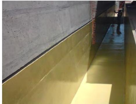
Fotografía 5 Recubrimiento de Muros con sistema Antiácido
