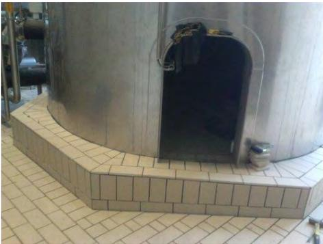
Fotografía 4 Instalación de Loseta en Base de Tanque
