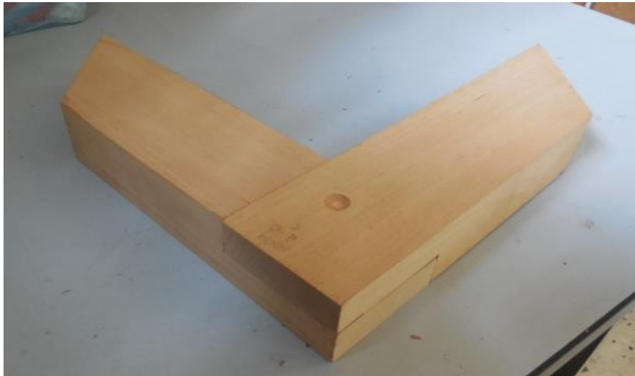
Figura 1. Ensamble a media madera
