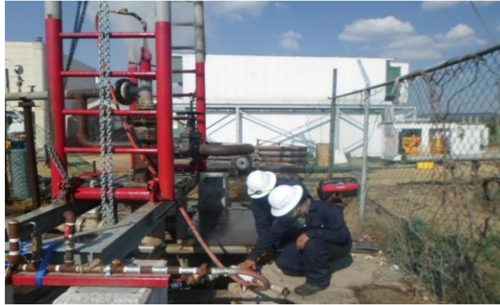
Figura 9. Instalación de la línea de hidrante de emergencia.
