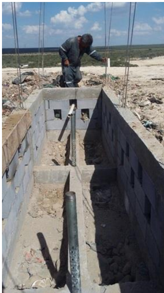
Imagen 5. Preparación para la base del quemador.
