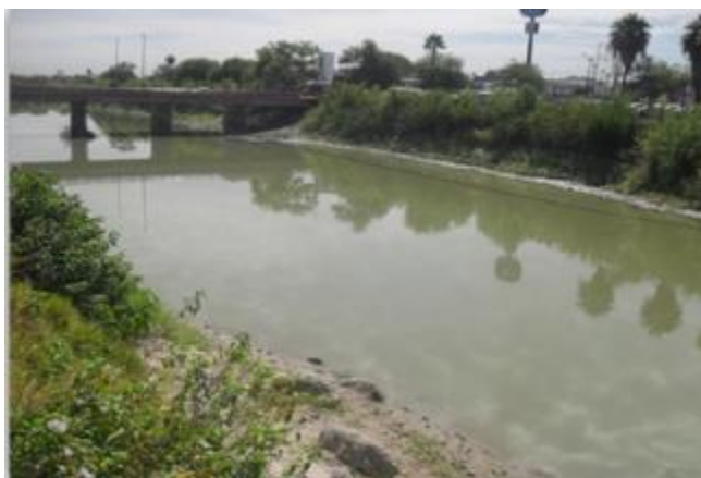
Imagen 6. Muestra del Canal en Estado Actual con el esquema del mal estado y cuidado de la zona.
