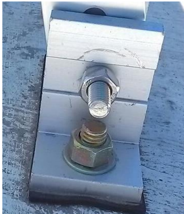
Figura 3. Anclaje de soporte con protección al par galvánico.
