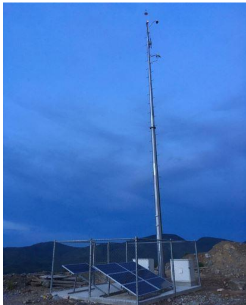
Figura 7. Obra terminada, cámara instalada.
