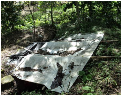
Figura 3. Obra de captación
