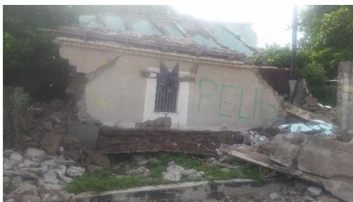
*Figura 4- Edificación con muros de adobe*
