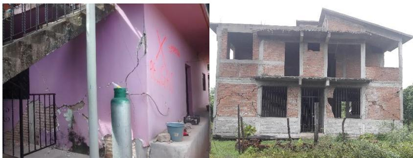
Figura 6- Cortante en muros
