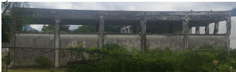
*Figura 1- Falla por condición de columna corta en escuela agropecuaria*
