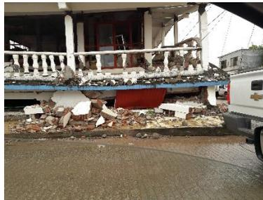
Figura 5- Escasez de elementos resistentes
