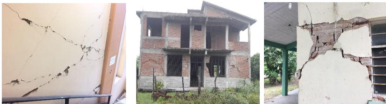
Figura 4- Falla por cortante en muro. Dos confinados y uno sin confinar.
