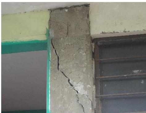
Figura 1- Cortante en columnas de concreto.
