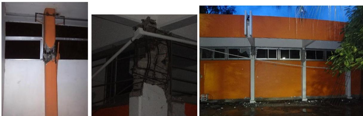
Figura 3- Falla por la condición de columna corta.
