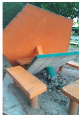
Figura 2- Flexión en columnas de concreto.
