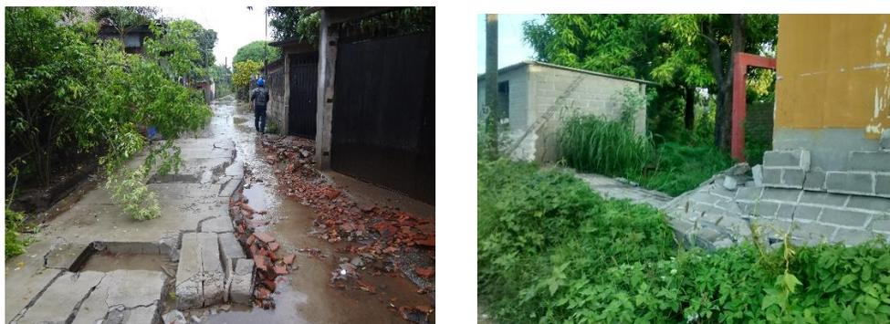
Figura 5- Falla en bardas perimetrales.
