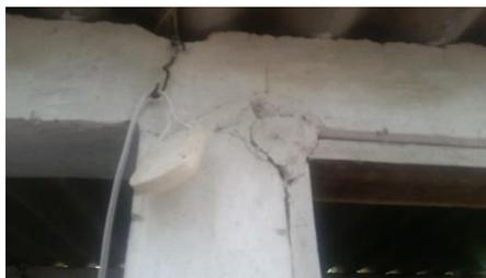
*Figura 3- Agrietamiento en nudo trabe-columna*
