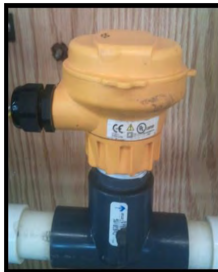
Figura 3. Transmisor indicador de flujo marca GF+ Signet 2537
