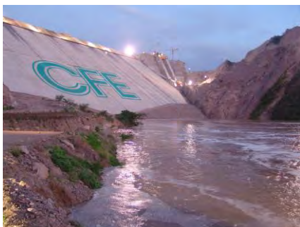
Figura 1.- Vista del cuerpo de la cortina, cara aguas arriba
