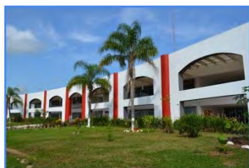
Figura 1: Sitio escogido para la instalación solar fotovoltaica en la UPC.
