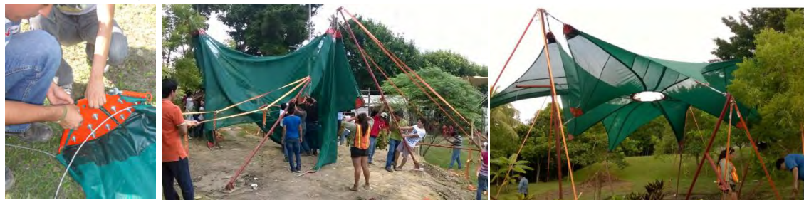
Figura. 25, 26, 27. Observamos el segundo proceso de montaje, el cual se corrigió las desviaciones de los puños metálicos, por lo que en el segundo izaje tenso toda la velaría y no se formaron arrugas que pudieran dañar la estructura. Fuente: Morales (2014).
