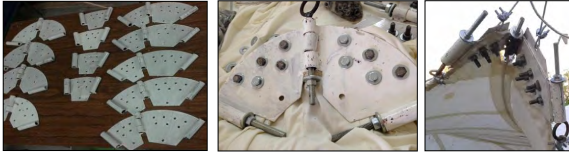
Figura. 15, 16, 17. Las conexiones metálicas tuvieron una función muy importante para este proyecto académico, ya que ellas constituyen los puntos de anclajes de la velaría, estos miembros rígidos articulados ayudan a mantener el equilibrio de esta tensoestructura. Fuente: Morales (2013).
