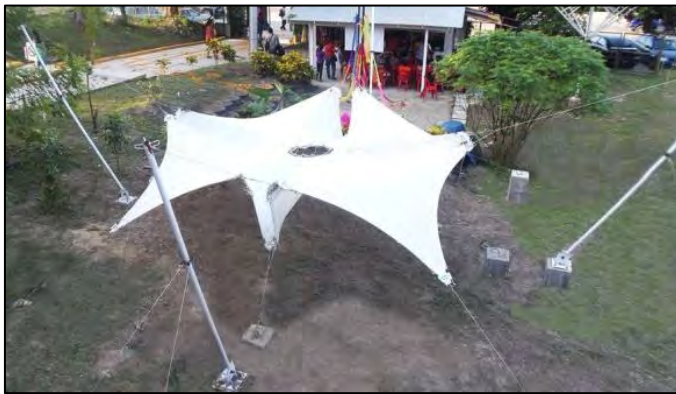
Figura. 15, 16, 17. Las conexiones metálicas tuvieron una función muy importante para este proyecto académico, ya que ellas constituyen los puntos de anclajes de la velaría, estos miembros rígidos articulados ayudan a mantener el equilibrio de esta tensoestructura. Fuente: Morales (2013).
