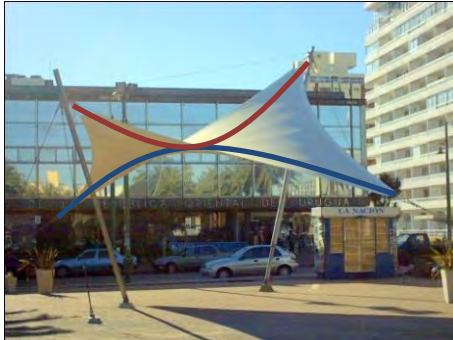
Figura. 1. La superficie de una velaría está formada por dos fuerzas; tracción y compresión. Fuente: Morales, (2013).
