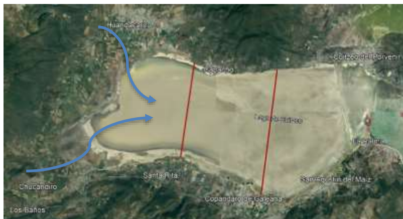
Figura 5. Construcción de bordos de contención de los escurrimientos de la cuenca y los principales escurrimientos
