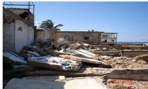
Fotos 12 y 13. Derrumbe total producto del impacto de las olas en fachadas cerradas Fuente: Tesis Diplo. Grecia Chediak Dirección Municipal de la Defensa Civil. Playa. Cuba
