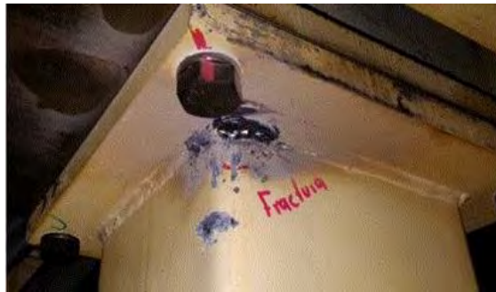
Figura 5. Aplicación de mantenimiento correctivo.
