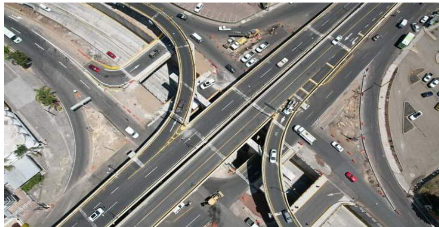
Imagen 3. Avance de la obra al 98% Abril de 2023.
