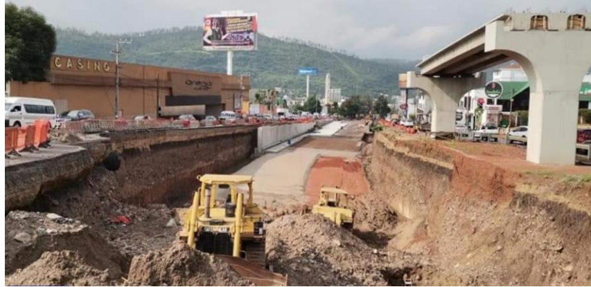
Imagen 2. Avances de la obra a 2 años del inicio de su construcción.
