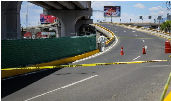
Imagen 4. Abril de 2023, obra con un avance del 99% Peritos realizando peritaje tras accidente vial.
