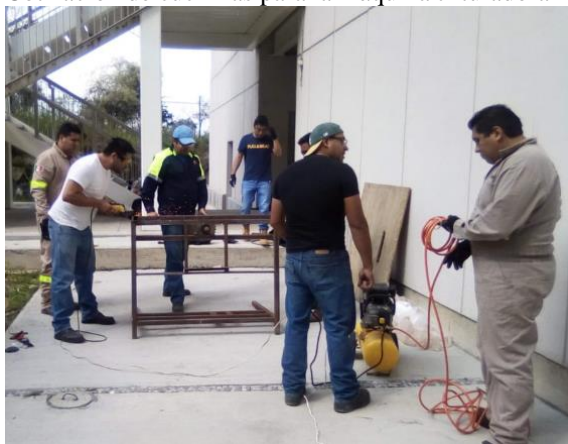
Figura 1. Fase 1 de la construcción de la máquina
