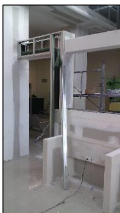
Figura 4. Estructura metálica para puertas y paso de tubería
