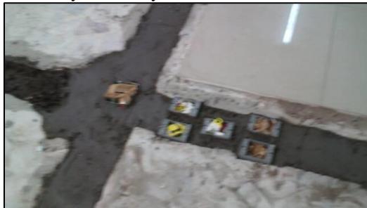
Figura 6. Zanja par cableado eléctrico y de datos
