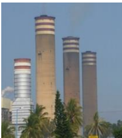
Figura 1. Chimenea de la Termoeléctrica de Tuxpan
