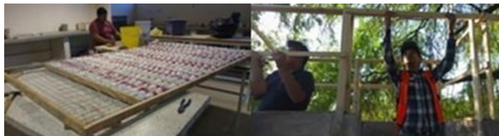
Figura 10. Techumbre base pets y acabados.
