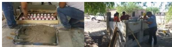
Figura 9. Construcción e instalación de block muro base pets.
