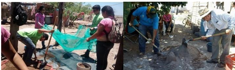
Figura 2. Cribado (tierra y arena) y mezclado.
