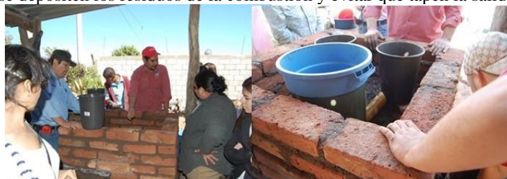
Figura 4. Construcción de la estufa.
