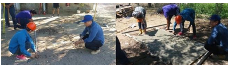
Figura 7. Localización Trazo y despalme del terreno y Losa de cimentación.
