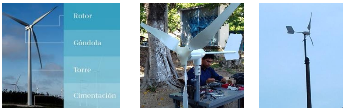
Figura 2.- Componentes de un aerogenerador horizontal.
