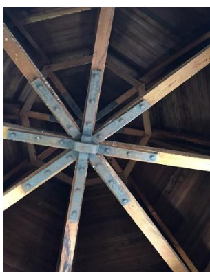
Figura 9. Interior de la cúpula
