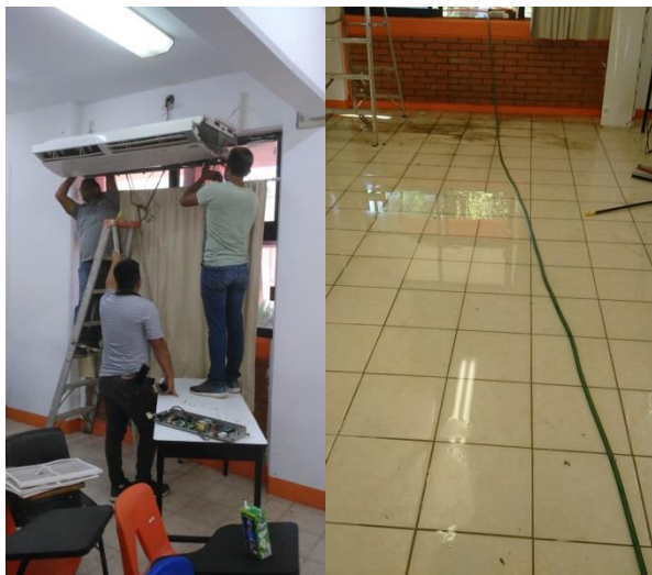
Figura 1. Mantenimiento de aire acondicionado en aulas.
