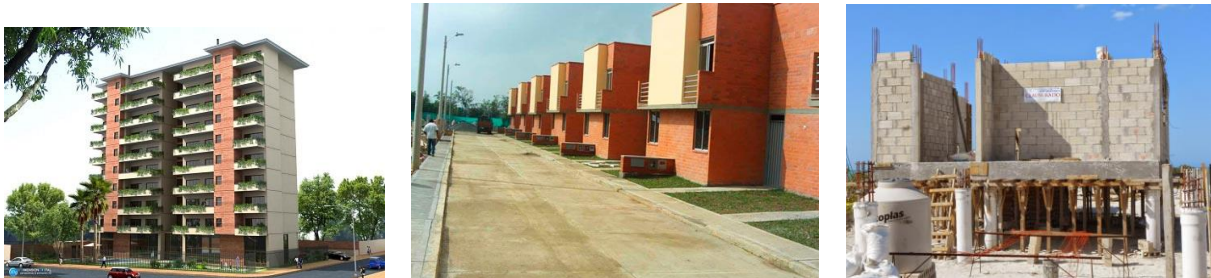
Imágenes 6 Tipología de Construcción.
