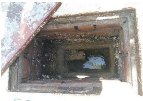
Imagen 3. Registro con material retenido provocando azolve.
