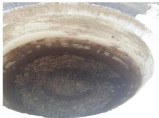
Imagen 4. Pozo de visita con gran cantidad de material que detiene el flujo del agua.
