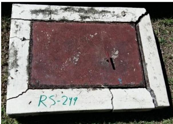
Imagen 1. Marco y tapa de registro sanitario en malas condiciones.
