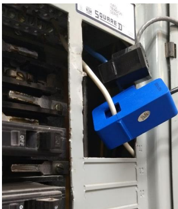
Figura 3. Colocación del transformador en la fase de interés.
