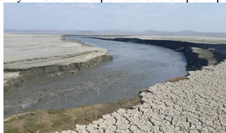
Figura 6. Evidencia del canal formado dentro del embalse, para un caudal de 40 m 3 /s a una cota de 90 m.
