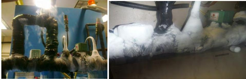
Figura 6. Sistema de tuberías congeladas por fugas de nitrógeno
