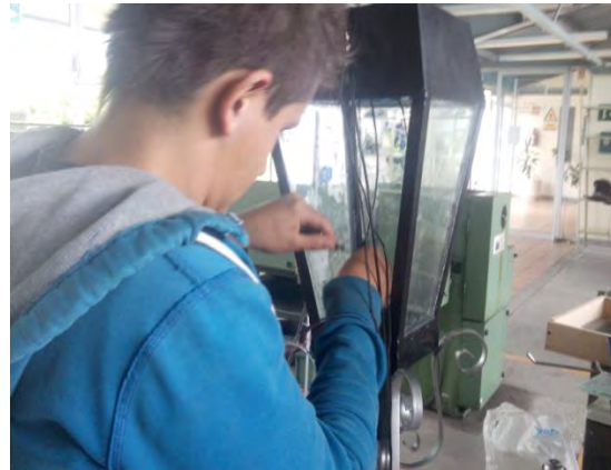
Fig. 4, en la imagen se observa la instalación del cableado utilizado para la conexión de la bombilla y el panel solar.
