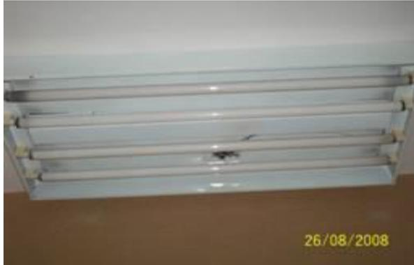
Figura No.3 Luminaria existente 4 x 39 W
