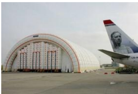
Figura 1. Hangar inflable de baja presión perteneciente al aeropuerto de Budapest, Hungría.
